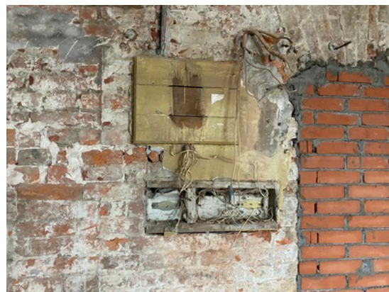
Фото № 6 - Внутреннее состояние
