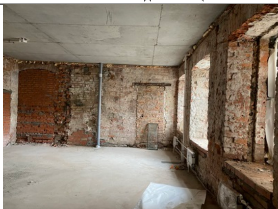
Фото № 3 – Внутреннее состояние
