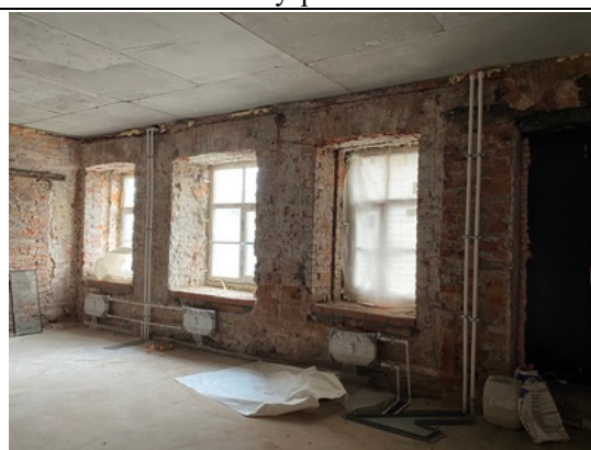
Фото № 4 – Внутреннее состояние
