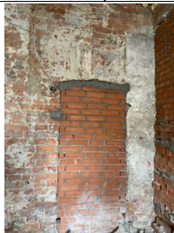
Фото № 2 – Внутреннее состояние
