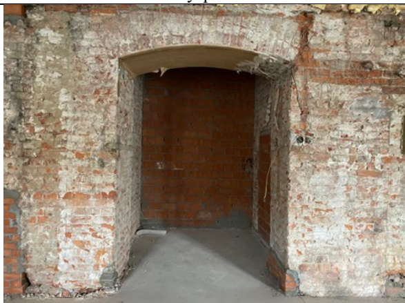
Фото № 5 – Внутреннее состояние
