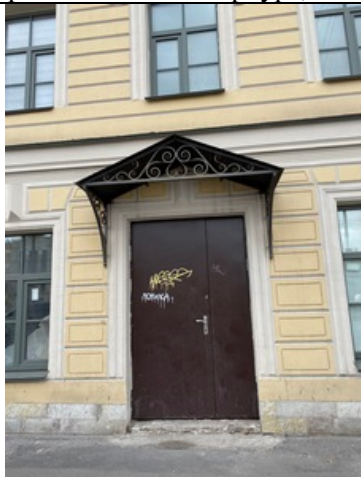
Фото № 1 – Вход в помещение
