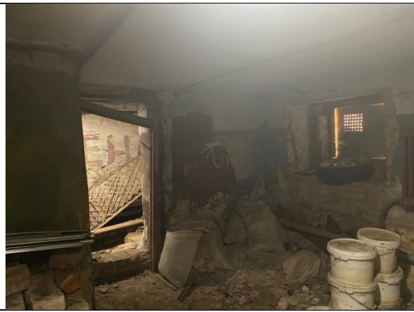
Фото 13. Внутреннее состояние Объекта оценки
