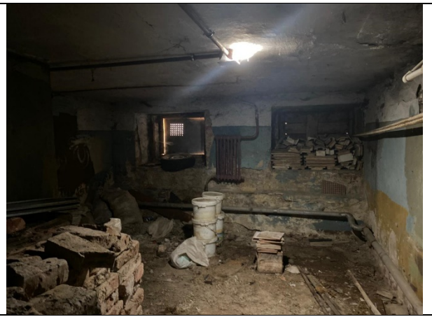
Фото 14. Внутреннее состояние Объекта оценки
