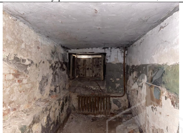
Фото 20. Внутреннее состояние Объекта оценки
