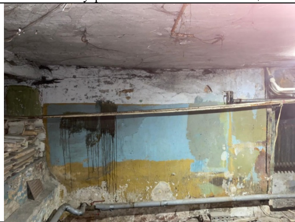
Фото 15. Внутреннее состояние Объекта оценки
