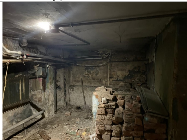
Фото 17. Внутреннее состояние Объекта оценки
