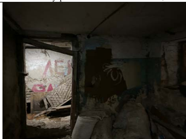
Фото 19. Внутреннее состояние Объекта оценки
