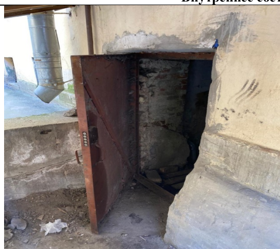
Фото 11. Внутреннее состояние Объекта оценки
