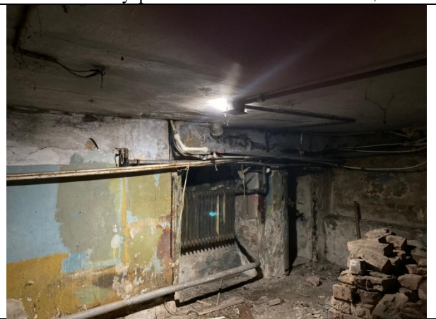
Фото 16. Внутреннее состояние Объекта оценки
