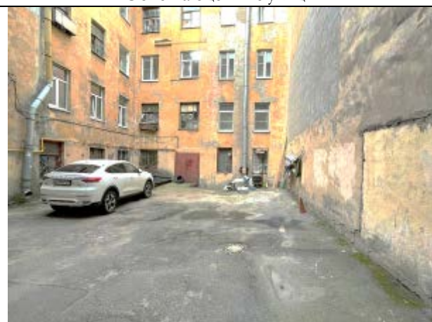
Фото 16. Внутри дворовая территория здания расположения Объекта оценки
