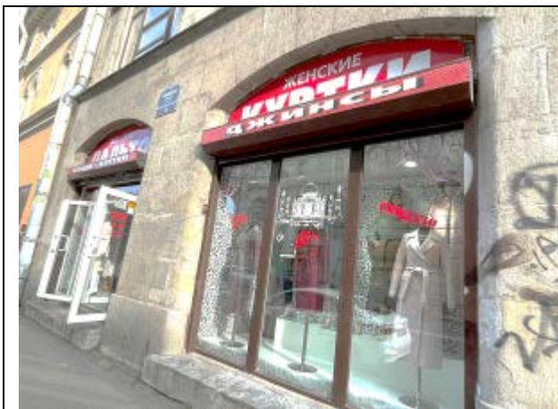
Фото 3. Ближайшее окружение Объекта оценки (Апраксин переулок)
