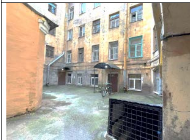
Фото 17. Внутри дворовая территория здания расположения Объекта оценки
