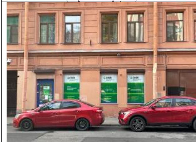
Фото 9. Ближайшее окружение Объекта оценки (Апраксин переулок)
