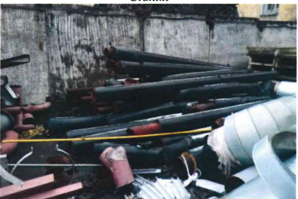
Демонтированные трубы (лом 12А)
