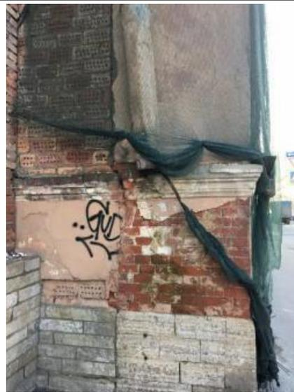
Фото 8. Состояние кирпичной кладки и наружной отделки стен
