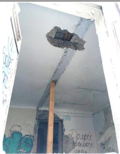
Фото 12. Типовое состояние внутренней отделки помещений 1 этажа: отпадение штукатурки, отслоение и отставание окрасочного слоя, сырые пятна, временные подпорки перекрытий
