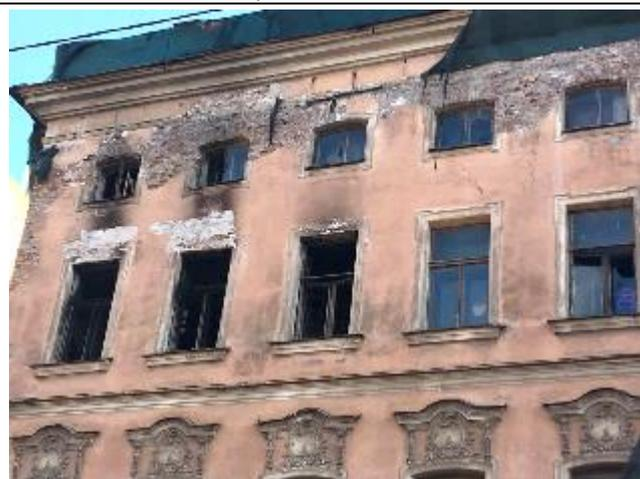
Фото 3. Следы пожара на 3 этаже. Трещины стен, отпадение штукатурки. Вид со стороны ул. Тюшина
