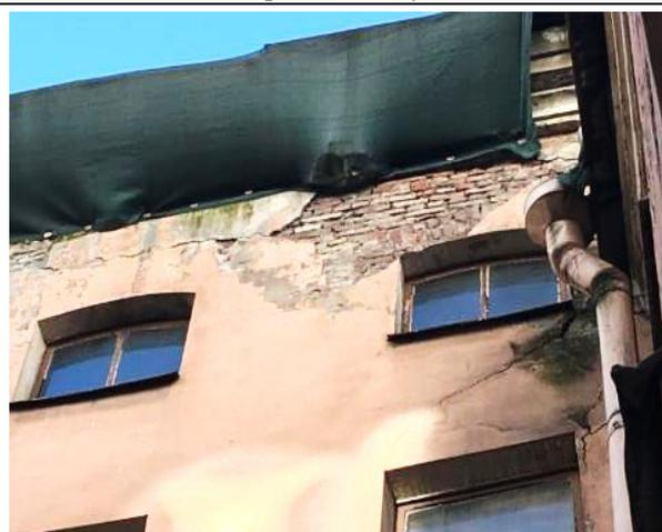
Фото 4. Состояние кирпичной кладки и наружной отделки стен со двора
