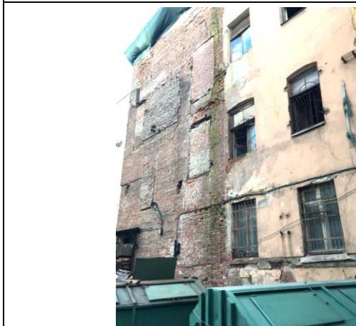
Фото 5. Дворовая территория. Состояние фасада здания со двора: кирпичная кладка оконных проемов, трещины, зазоры в стенах
