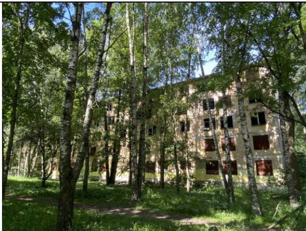
Фото 3. Вид на здание Объекта оценки с Адмиралтейской улицы.
