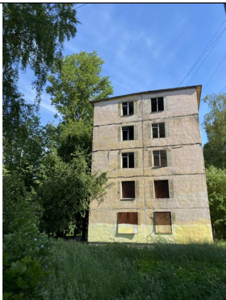
Фото 7. Вид на здание Объекта оценки.
