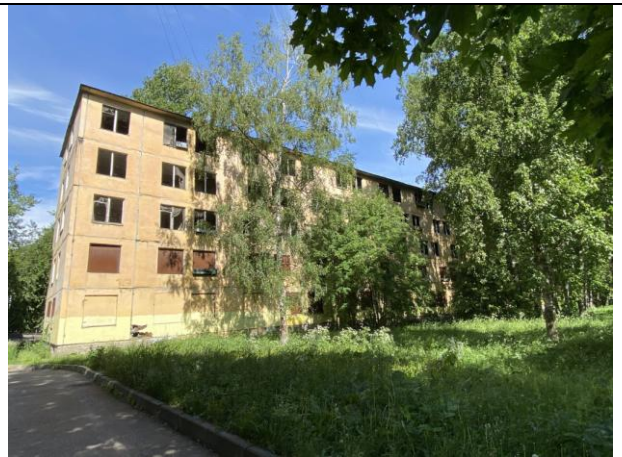
Фото 4. Вид на здание Объекта оценки с Адмиралтейской улицы.
