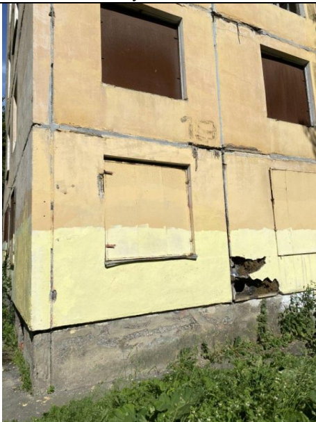
Фото 5. Состояние Объекта оценки.
