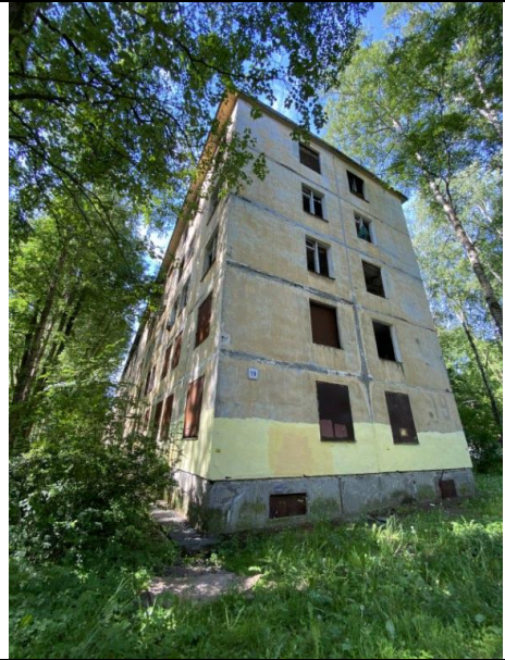
Фото 2. Вид на здание Объекта оценки.
