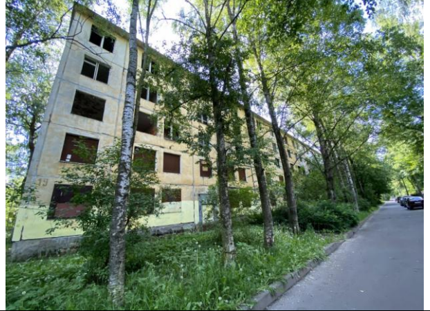
Фото 16. Вид на здание Объекта оценки со двора.
