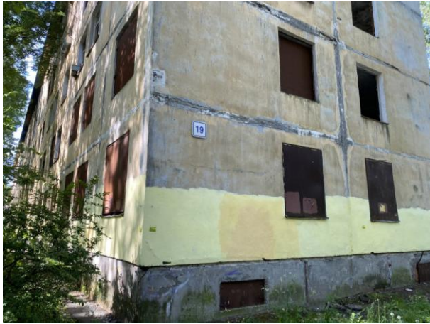
Фото 1. Вид на здание Объекта оценки.
