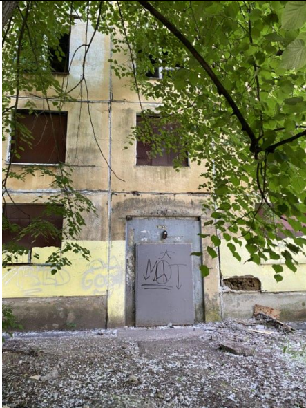
Фото 21. Вход в подъезд Объекта оценки.
