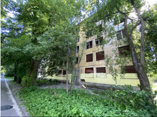
Фото 15. Вид на здание Объекта оценки со двора.
