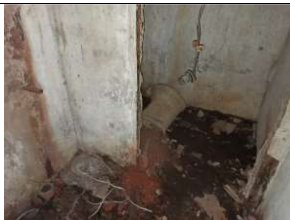
Фото 14. Внутреннее состояние Объекта оценки
