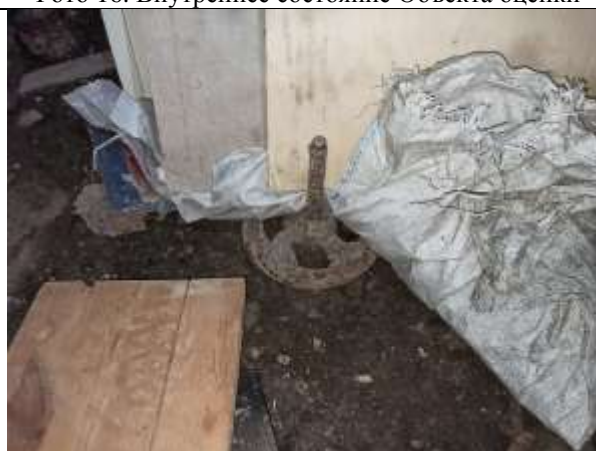
Фото 18. Внутреннее состояние Объекта оценки
