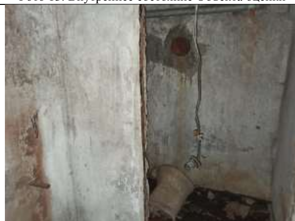
Фото 15. Внутреннее состояние Объекта оценки
