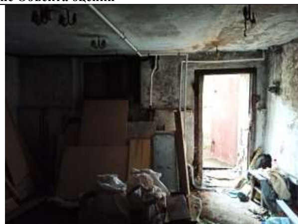
Фото 12. Внутреннее состояние Объекта оценки
