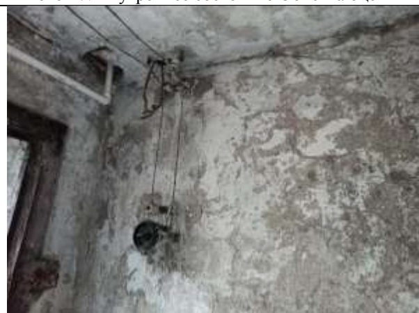
Фото 19. Внутреннее состояние Объекта оценки
