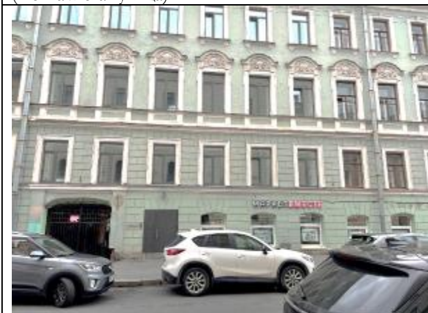
Фото 25. Вид здания Объекта оценки
