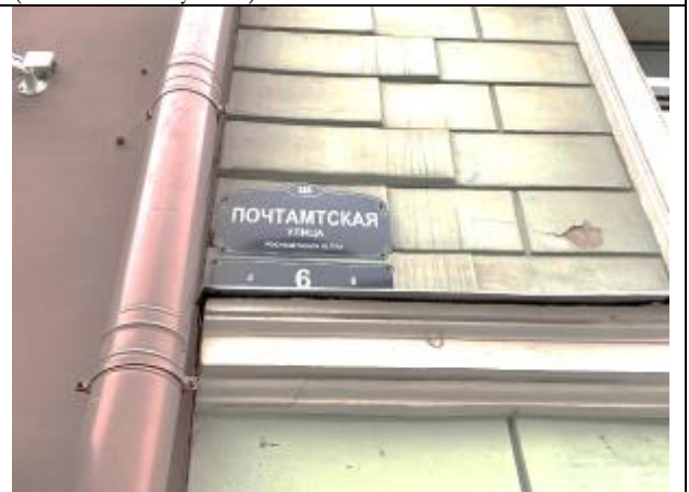
Фото 24. Адрес объекта оценки
