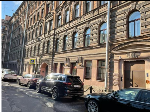
Фото 8. Вид здания расположения Объекта оценки
