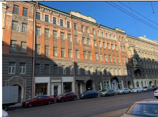
Фото 12. Вид здания расположения Объекта оценки
