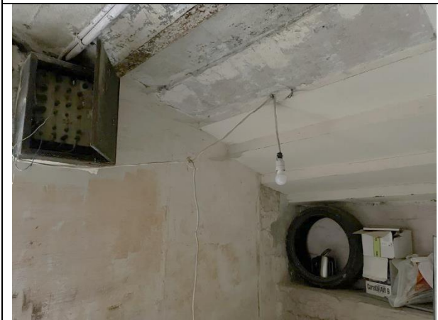
Фото 21. Типичное состояние Объекта оценки
