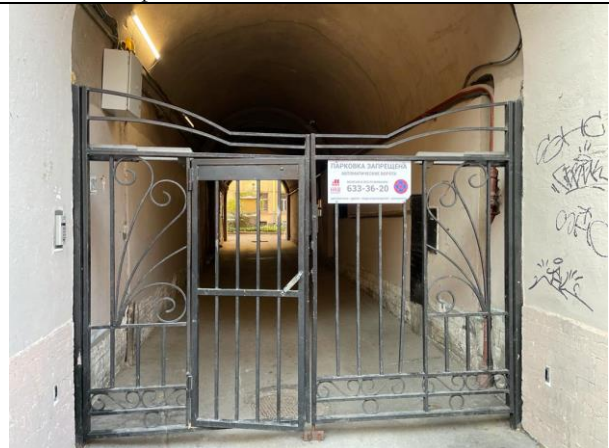
Фото 13. Вид арки, ведущей во двор расположения Объекта оценки
