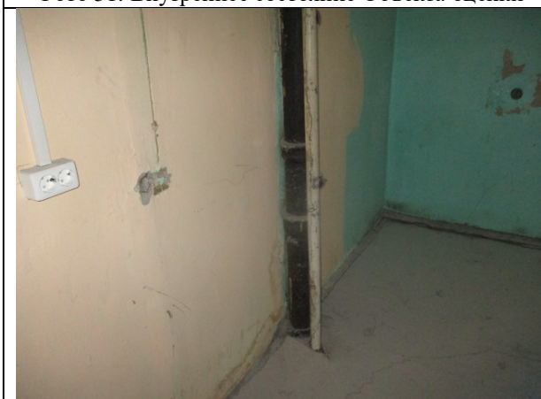
Фото 53. Внутреннее состояние Объекта оценки
