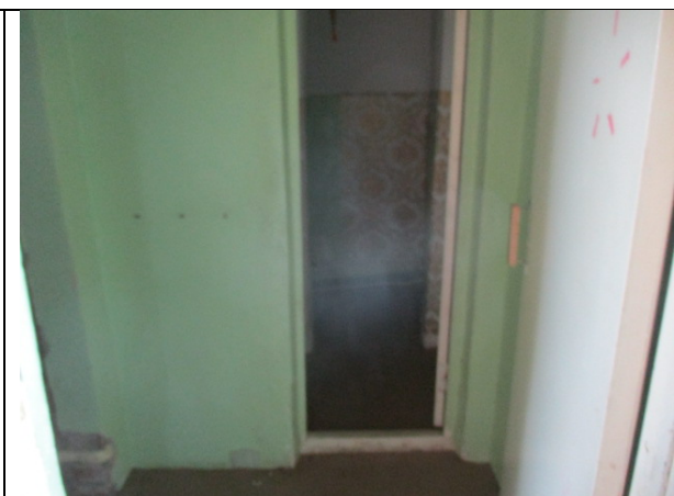
Фото 42. Внутреннее состояние Объекта оценки
