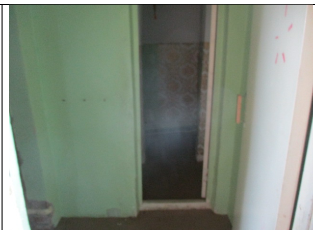
Фото 42. Внутреннее состояние Объекта оценки
