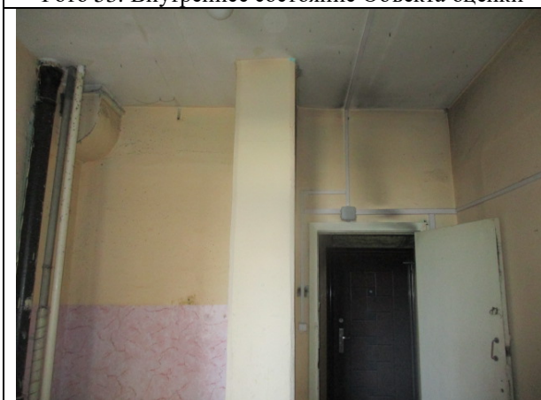
Фото 55. Внутреннее состояние Объекта оценки
