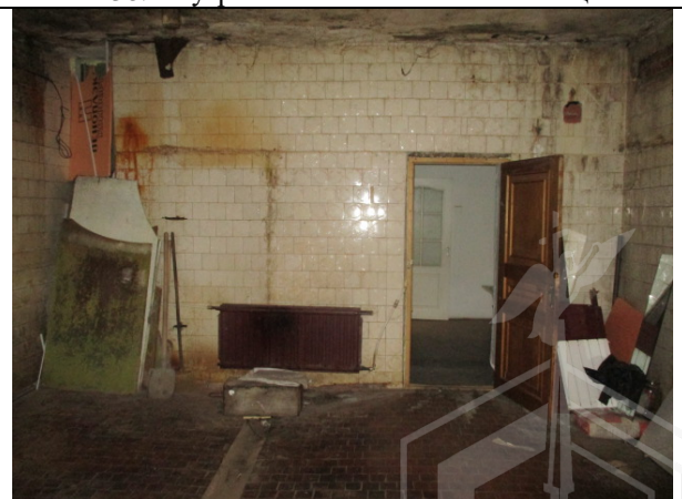
Фото 40. Внутреннее состояние Объекта оценки
