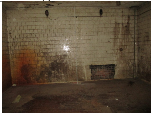
Фото 37. Внутреннее состояние Объекта оценки
