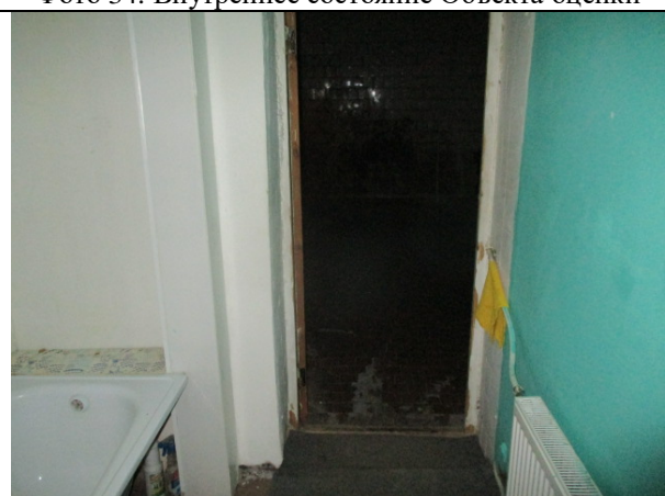
Фото 36. Внутреннее состояние Объекта оценки
