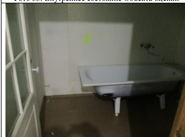
Фото 35. Внутреннее состояние Объекта оценки
