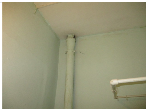
Фото 50. Внутреннее состояние Объекта оценки
