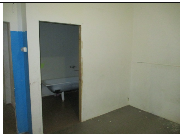
Фото 34. Внутреннее состояние Объекта оценки
