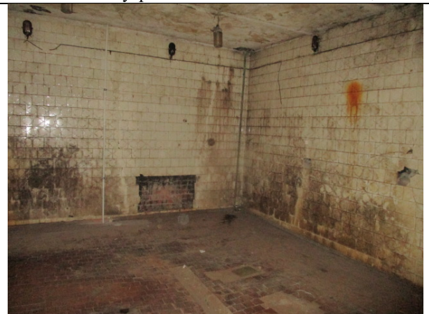
Фото 38. Внутреннее состояние Объекта оценки
