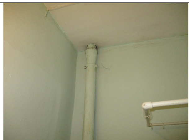
Фото 50. Внутреннее состояние Объекта оценки
