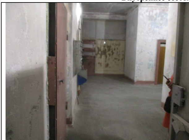
Фото 21. Внутреннее состояние Объекта оценки
