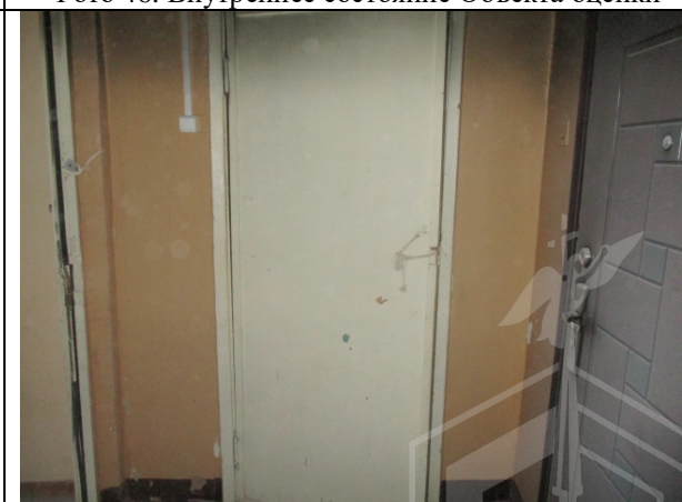
Фото 48. Внутреннее состояние Объекта оценки
