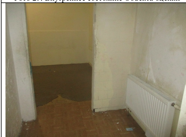
Фото 31. Внутреннее состояние Объекта оценки
