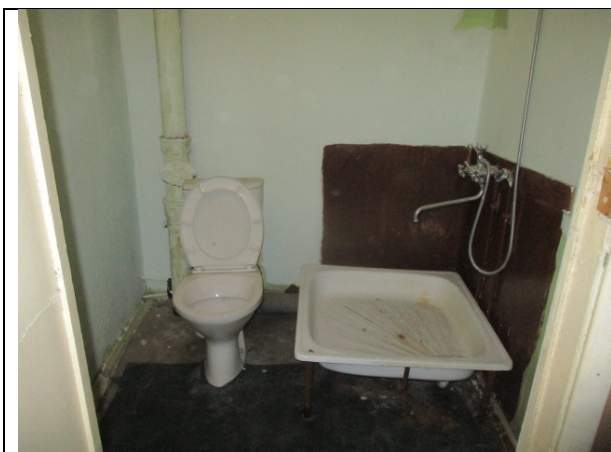
Фото 49. Внутреннее состояние Объекта оценки
