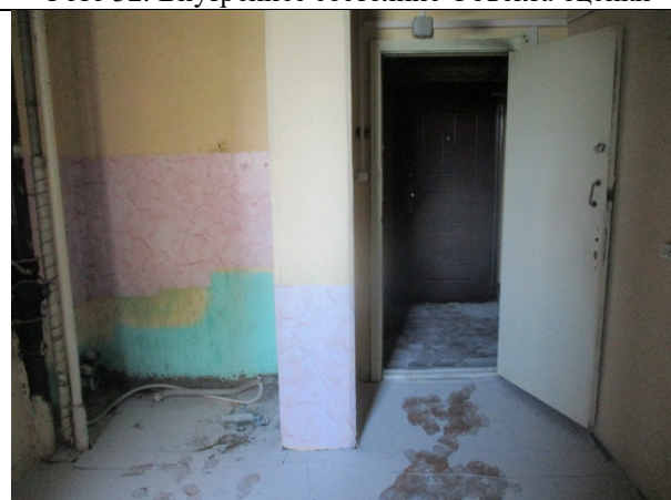
Фото 54. Внутреннее состояние Объекта оценки
