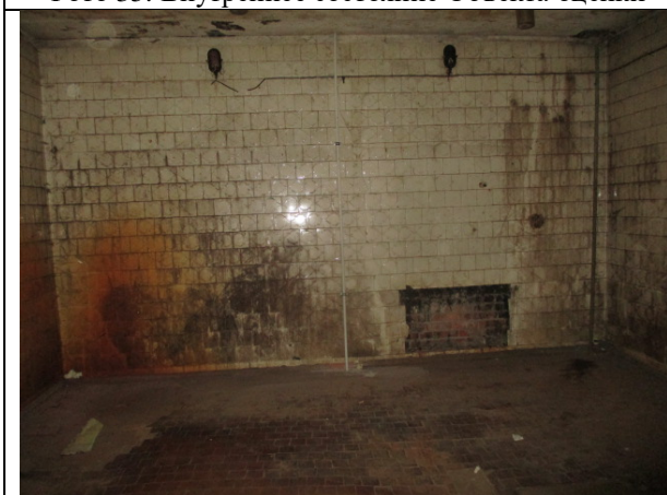
Фото 37. Внутреннее состояние Объекта оценки
