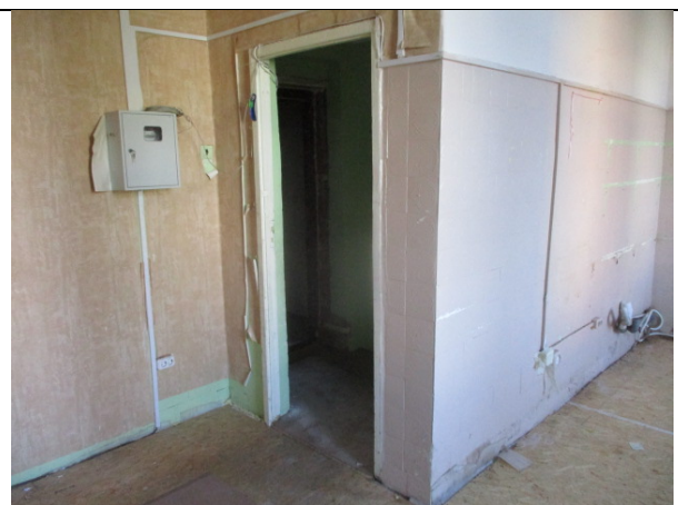
Фото 26. Внутреннее состояние Объекта оценки
