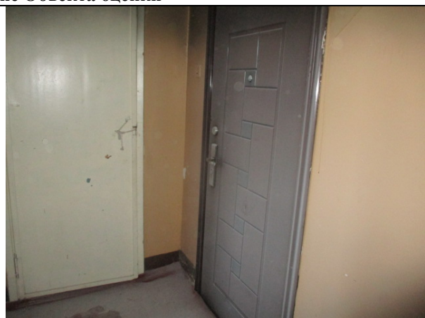
Фото 22. Внутреннее состояние Объекта оценки
