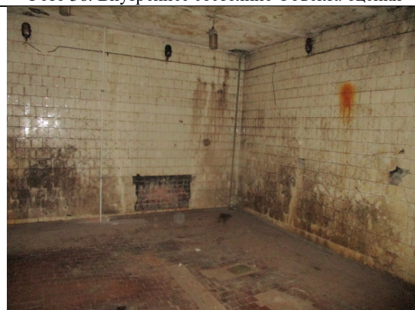
Фото 38. Внутреннее состояние Объекта оценки
