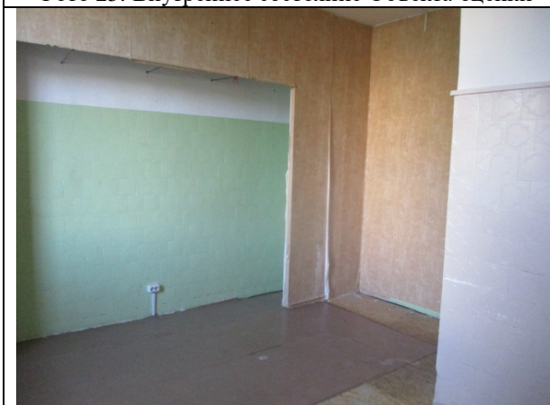
Фото 27. Внутреннее состояние Объекта оценки
