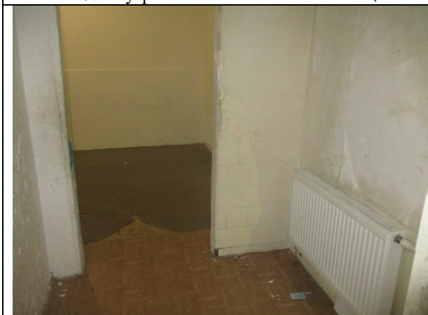
Фото 31. Внутреннее состояние Объекта оценки
