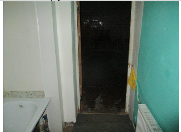
Фото 36. Внутреннее состояние Объекта оценки
