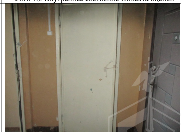
Фото 48. Внутреннее состояние Объекта оценки
