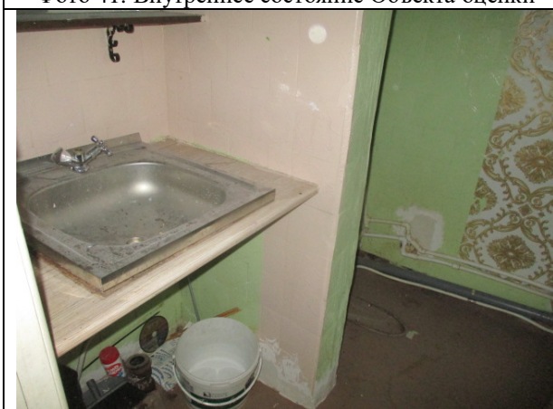
Фото 43. Внутреннее состояние Объекта оценки
