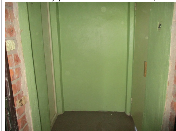
Фото 23. Внутреннее состояние Объекта оценки
