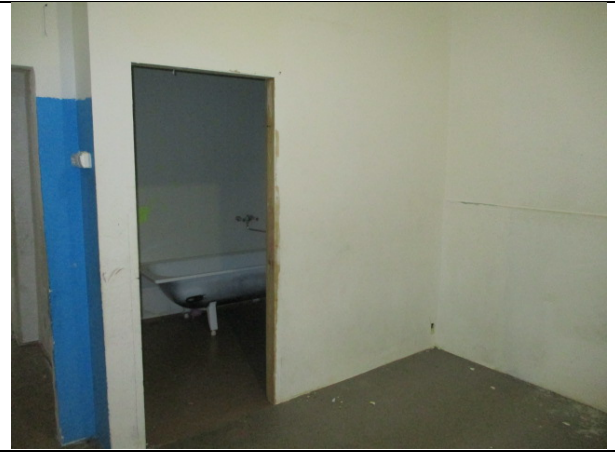
Фото 34. Внутреннее состояние Объекта оценки
