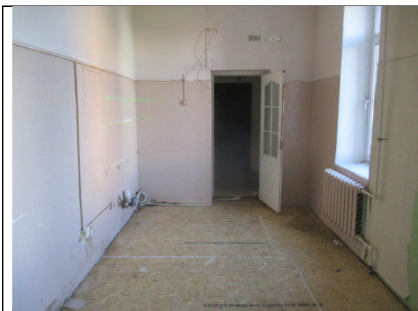
Фото 25. Внутреннее состояние Объекта оценки
