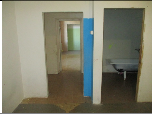
Фото 33. Внутреннее состояние Объекта оценки
