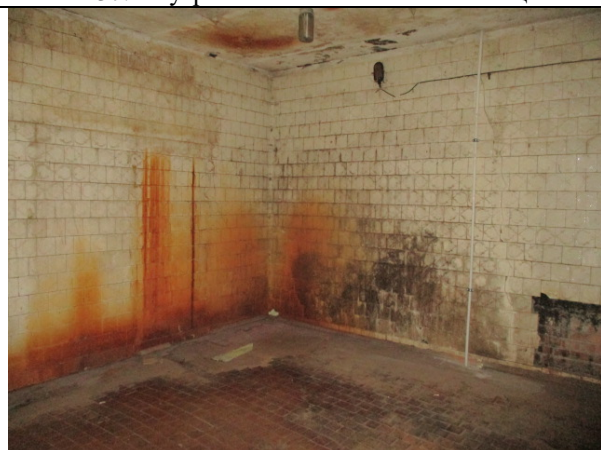
Фото 39. Внутреннее состояние Объекта оценки
