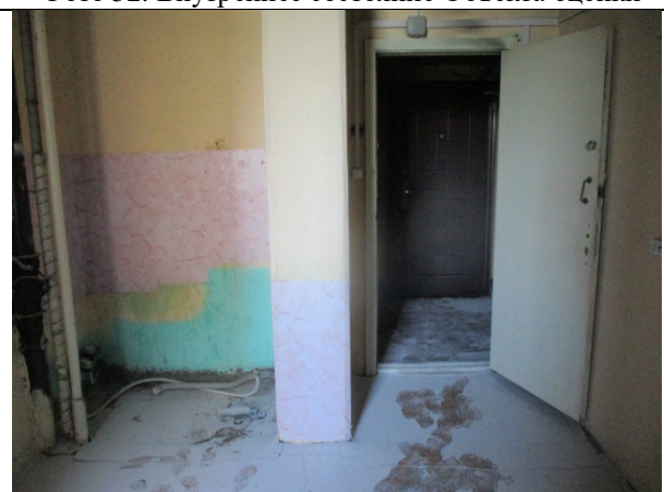
Фото 54. Внутреннее состояние Объекта оценки
