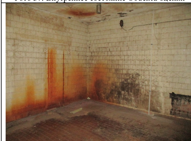
Фото 39. Внутреннее состояние Объекта оценки
