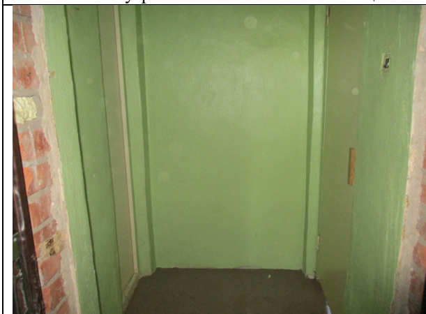
Фото 23. Внутреннее состояние Объекта оценки
