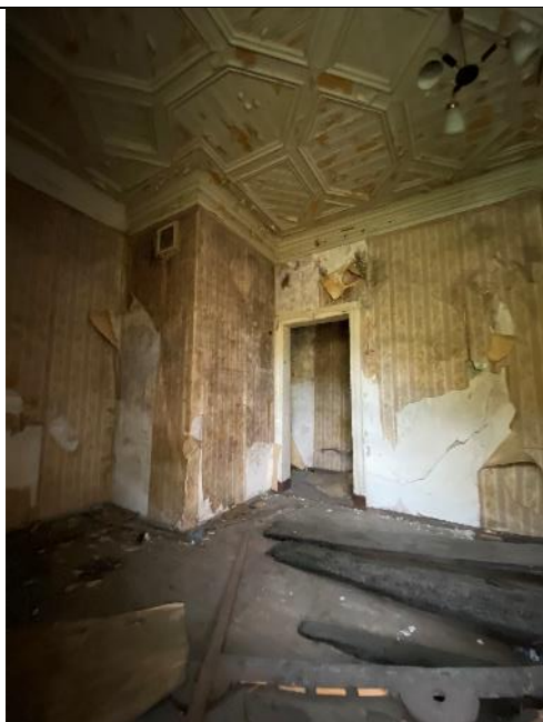
Фото №11: Внутреннее состояние
