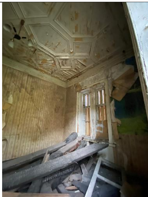
Фото №12: Внутреннее состояние
