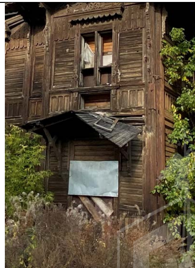
Фото №8: Заколоченный вход в здание
