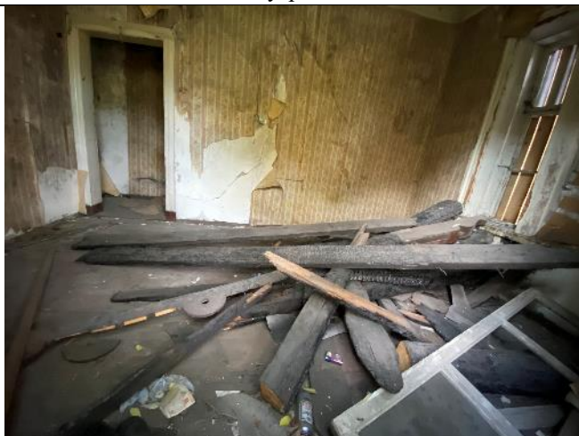
Фото № 13: Внутреннее состояние
