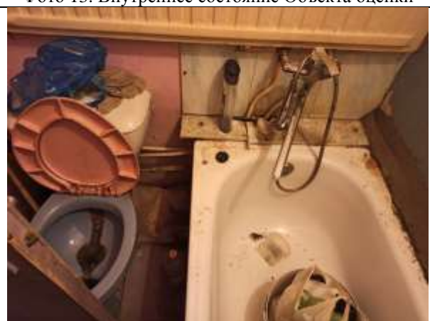
Фото 15. Внутреннее состояние Объекта оценки
