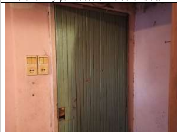
Фото 12. Внутреннее состояние Объекта оценки
