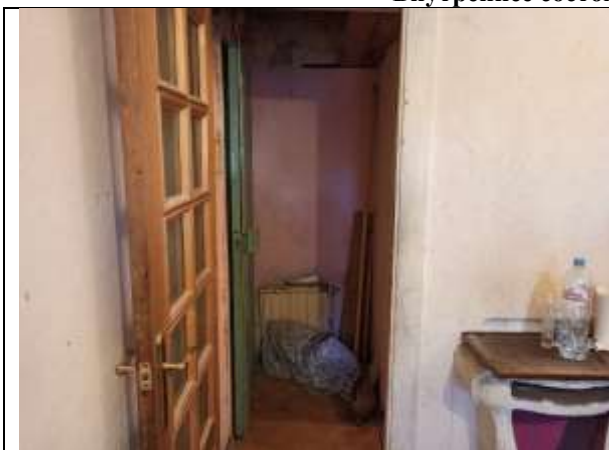
Фото 8. Внутреннее состояние Объекта оценки
