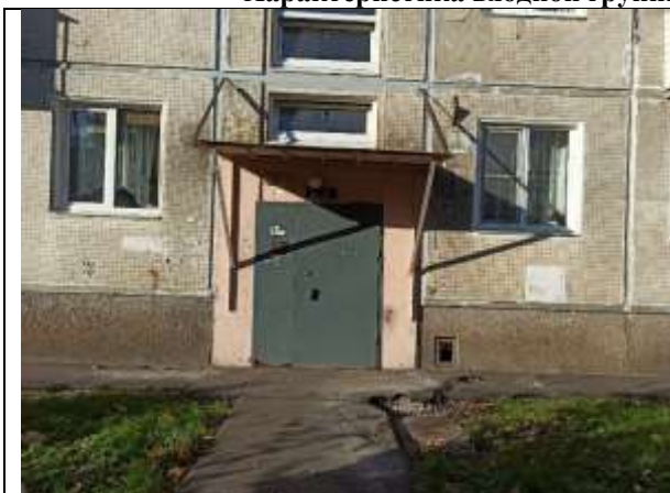
Фото 5. Общий вход со двора
