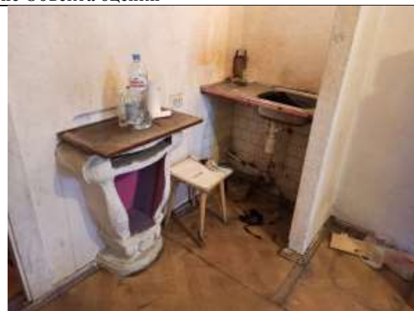
Фото 9. Внутреннее состояние Объекта оценки
