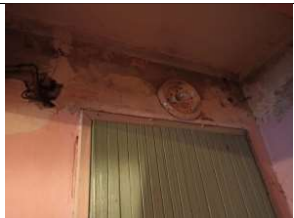
Фото 11. Внутреннее состояние Объекта оценки
