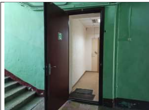
Фото 11. Вход в помещение
