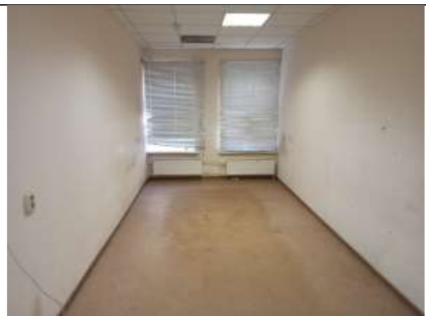
Фото 26. Внутреннее состояние Объекта оценки
