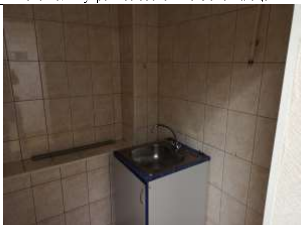
Фото 20. Внутреннее состояние Объекта оценки
