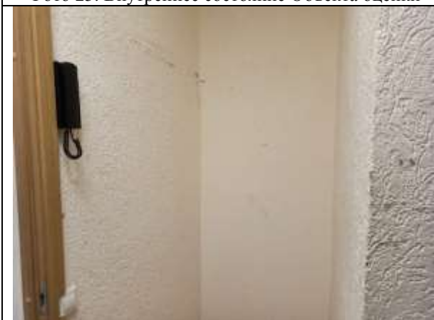
Фото 27. Внутреннее состояние Объекта оценки
