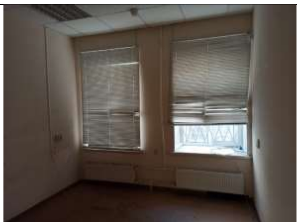
Фото 18. Внутреннее состояние Объекта оценки
