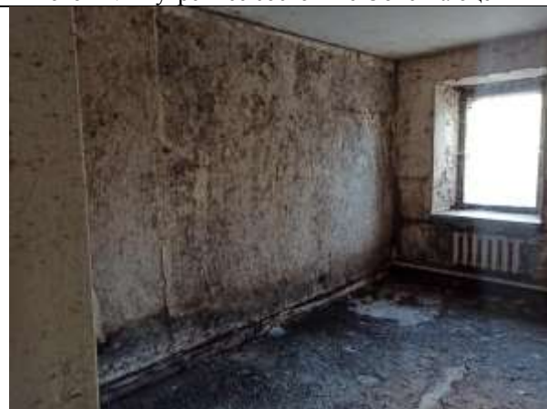
Фото 13. Внутреннее состояние Объекта оценки
