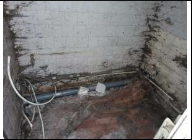
Фото 16. Внутреннее состояние Объекта оценки
