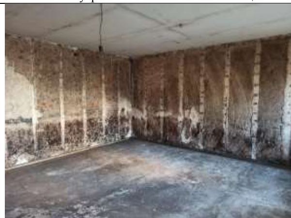
Фото 11. Внутреннее состояние Объекта оценки
