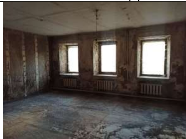
Фото 9. Внутреннее состояние Объекта оценки
