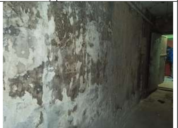
Фото 20. Внутреннее состояние Объекта оценки
