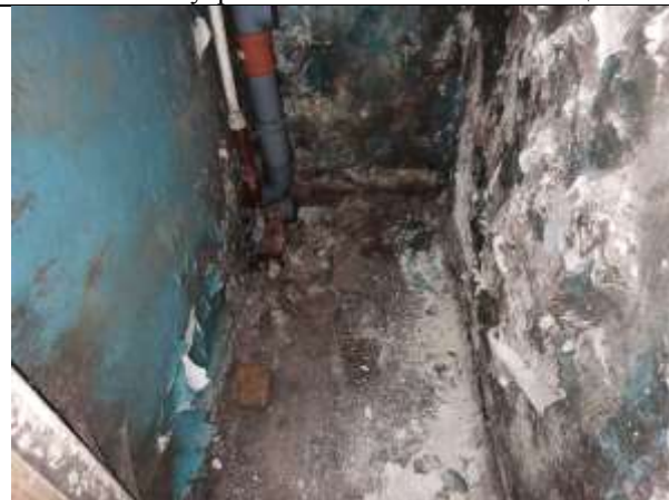
Фото 19. Внутреннее состояние Объекта оценки
