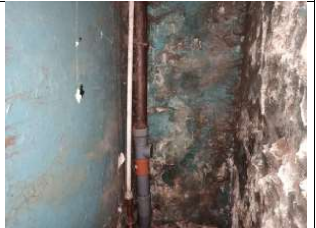
Фото 18. Внутреннее состояние Объекта оценки
