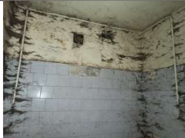
Фото 17. Внутреннее состояние Объекта оценки
