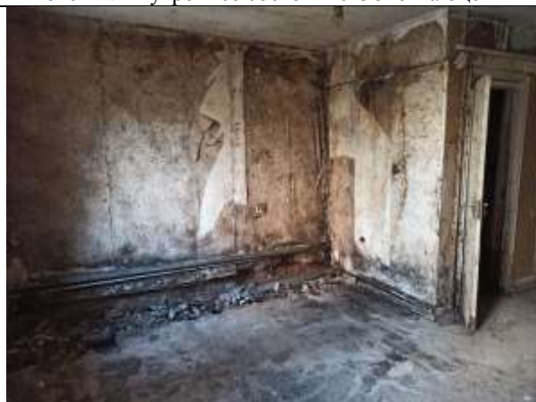
Фото 14. Внутреннее состояние Объекта оценки
