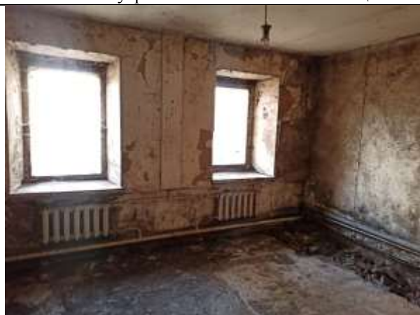
Фото 12. Внутреннее состояние Объекта оценки
