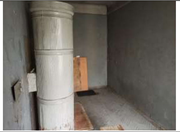
Фото 12. Внутреннее состояние Объекта оценки
