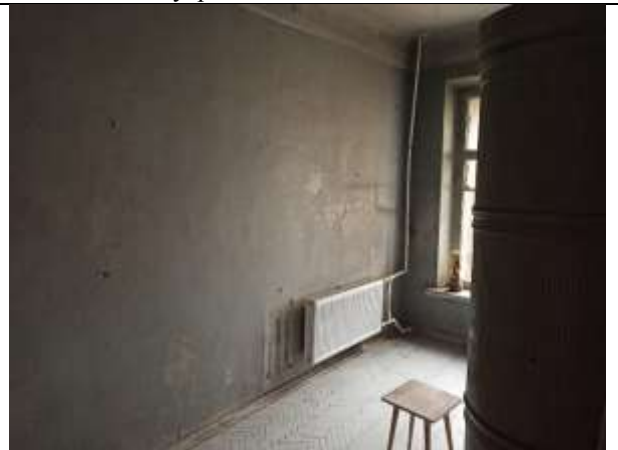
Фото 14. Внутреннее состояние Объекта оценки
