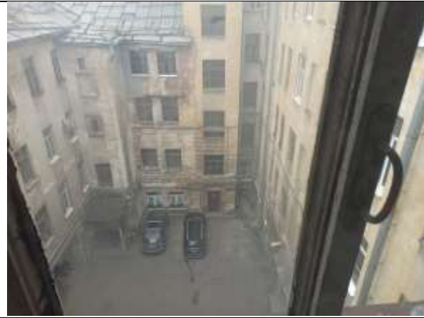
Фото 11. Внутреннее состояние Объекта оценки
