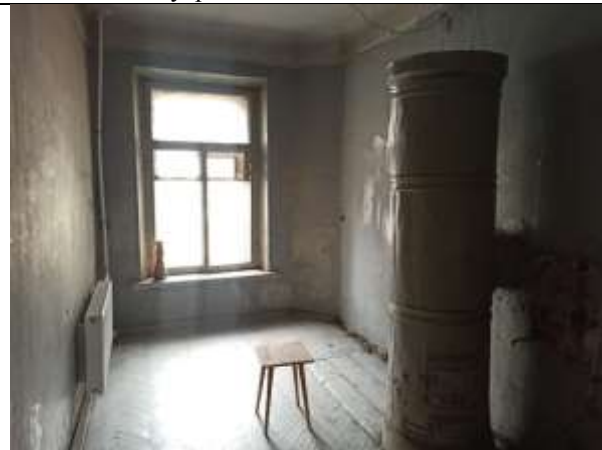
Фото 13. Внутреннее состояние Объекта оценки
