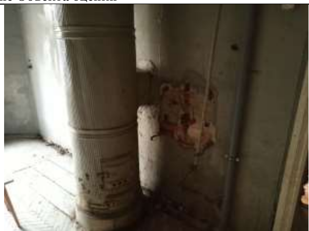
Фото 10. Внутреннее состояние Объекта оценки
