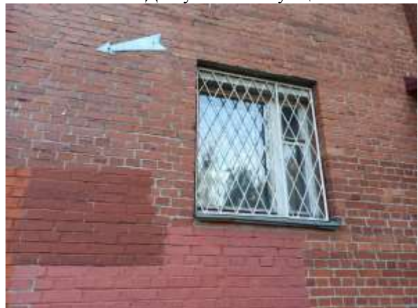
Фото 12. оконный проем во двор
