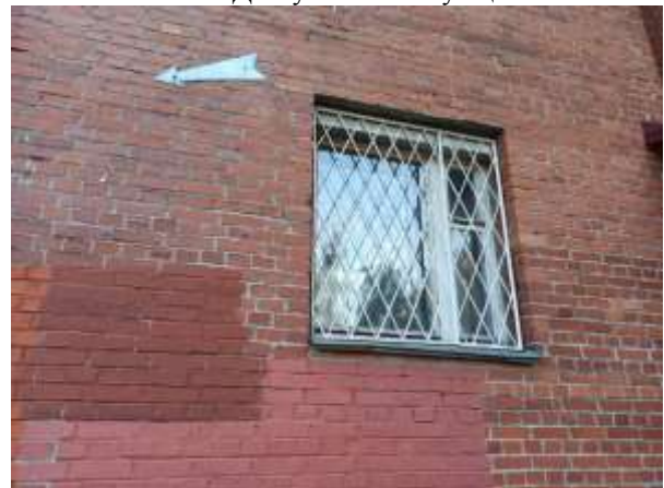
Фото 12. оконный проем во двор
