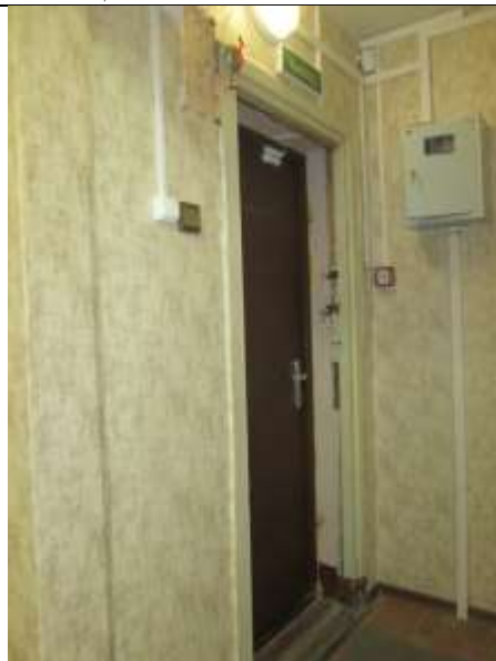
Фото 14. Внутреннее состояние Объекта оценки
