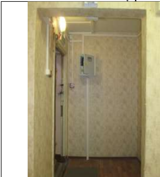
Фото 13. Внутреннее состояние Объекта оценки
