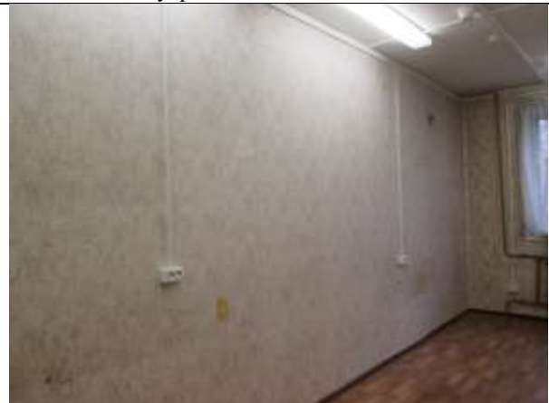
Фото 22. Внутреннее состояние Объекта оценки
