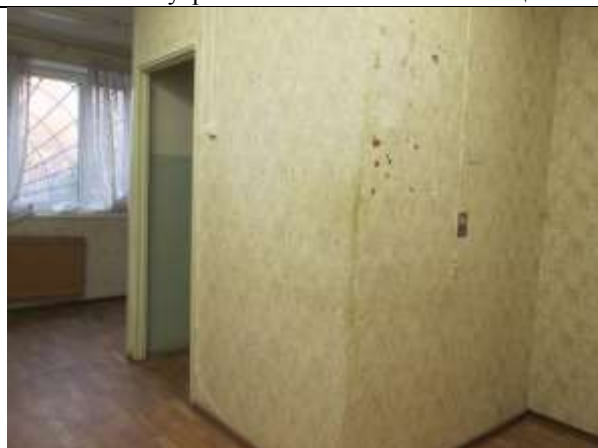
Фото 17. Внутреннее состояние Объекта оценки
