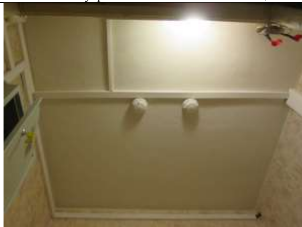
Фото 15. Внутреннее состояние Объекта оценки
