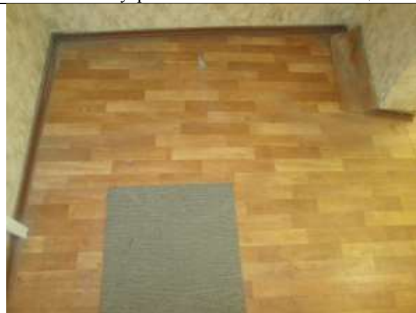
Фото 16. Внутреннее состояние Объекта оценки
