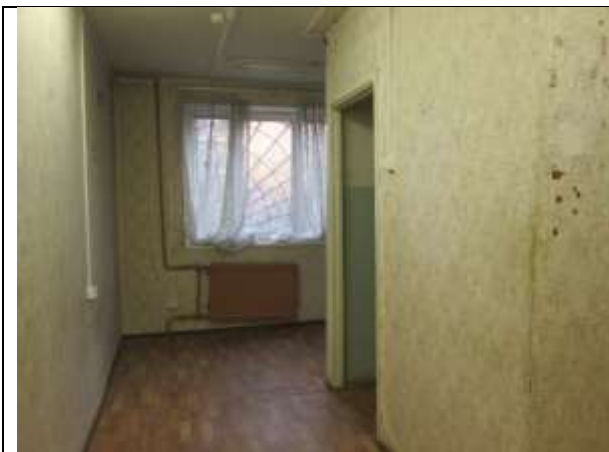
Фото 19. Внутреннее состояние Объекта оценки
