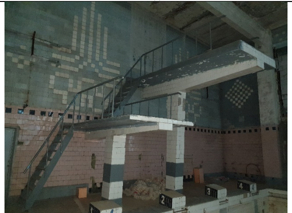
Фото №46: Вид бассейна
