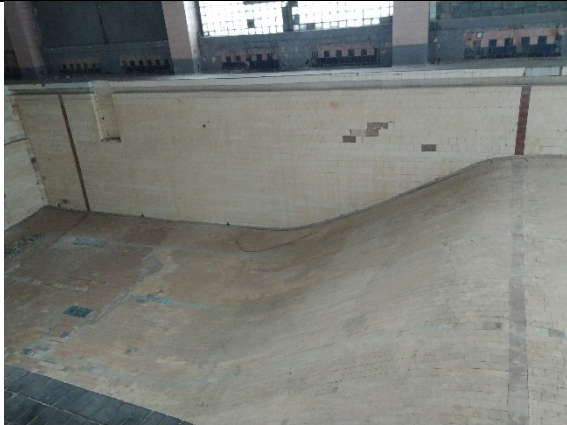
Фото №43: Вид бассейна
