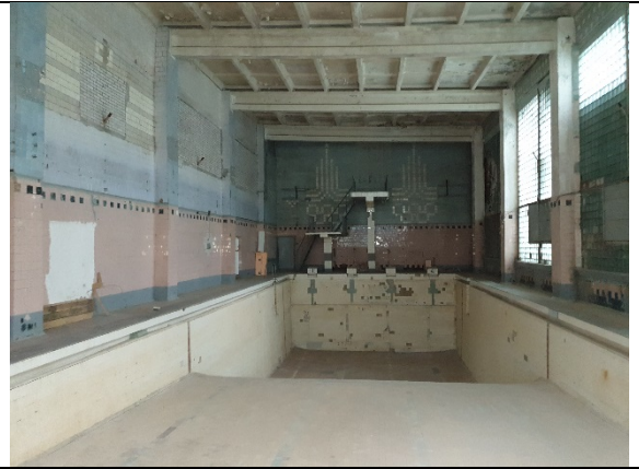
Фото №42: Вид бассейна
