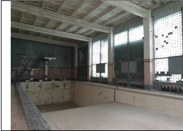
Фото №41: Вид бассейна
