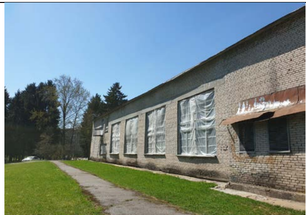
Фото №2: Внешний вид здания
