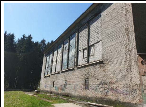
Фото №5: Внешний вид здания
