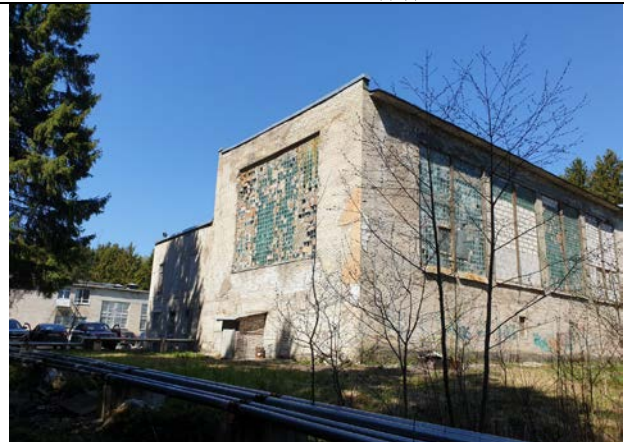
Фото №4: Внешний вид здания здания (окно в помещении с бассейном)
