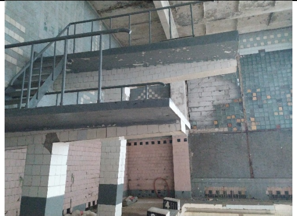
Фото №44: Вид бассейна
