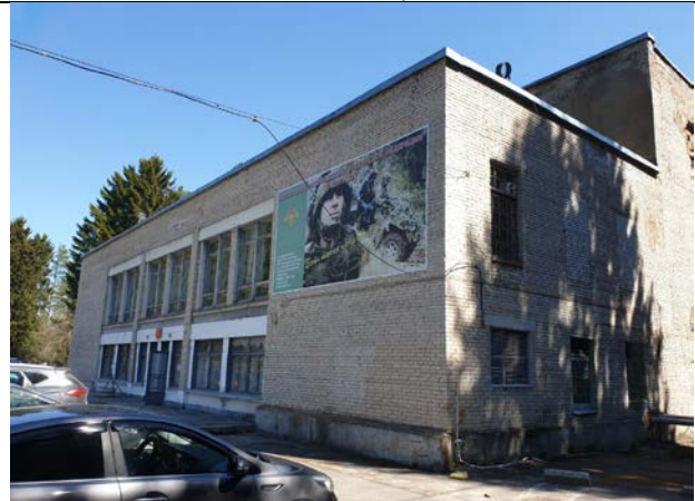
Фото №6: Главный вход в здание
