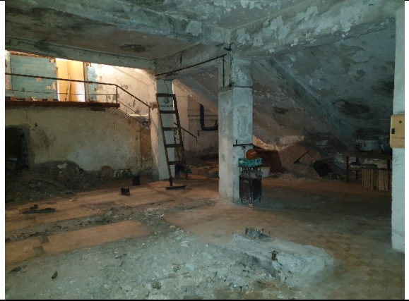
Фото №24: Дно чаши бассейна
