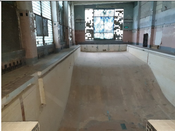
Фото №45: Вид бассейна
