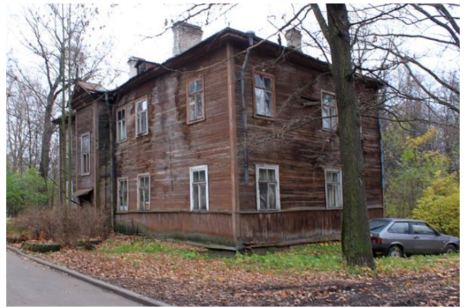
Фото 2. Вид на здание размещения Объекта оценки.
