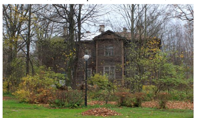
Фото 4. Вид на здание размещения Объекта оценки.
