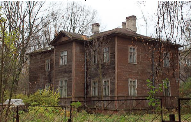
Фото 3. Вид на здание размещения Объекта оценки.
