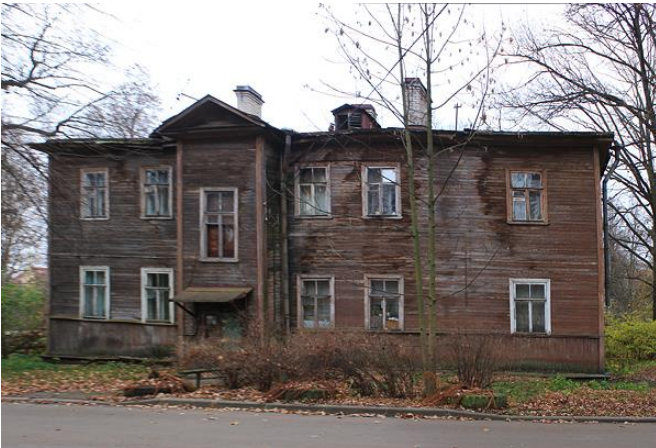
Фото 1. Вид на здание размещения Объекта оценки.
