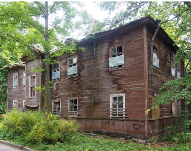
Фото 5. Вид на здание размещения Объекта оценки.
