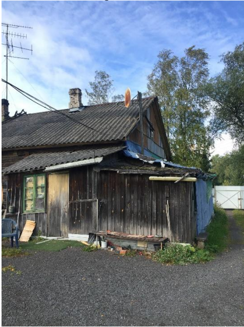
Фото 9. Вид на здание размещения Объекта оценки.
