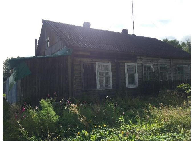
Фото 2. Вид на здание размещения Объекта оценки.
