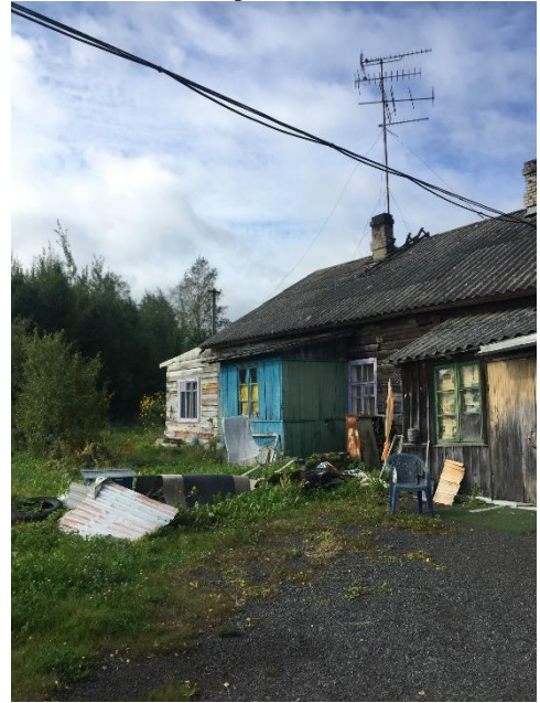
Фото 10. Вид на здание размещения Объекта оценки.
