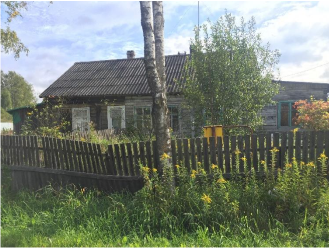
Фото 1. Вид на здание размещения Объекта оценки.
