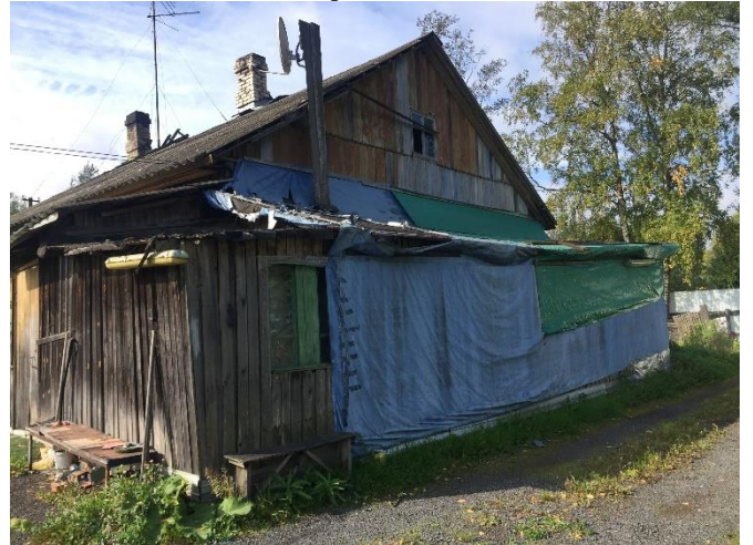
Фото 4. Вид на здание размещения Объекта оценки.
