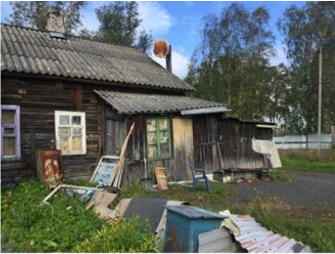
Фото 7. Вид на здание размещения Объекта оценки.
