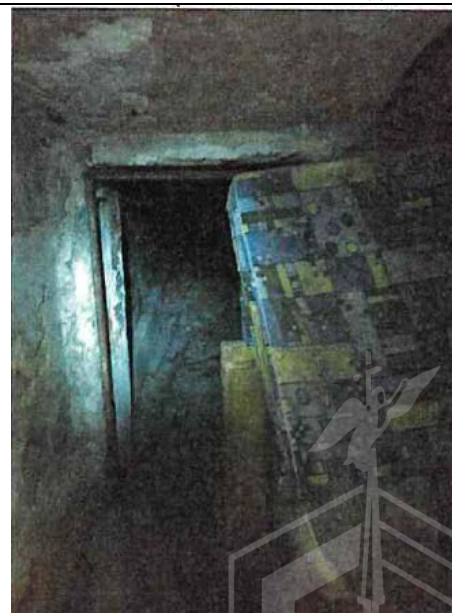
Фото № 6 – Вход в помещение
