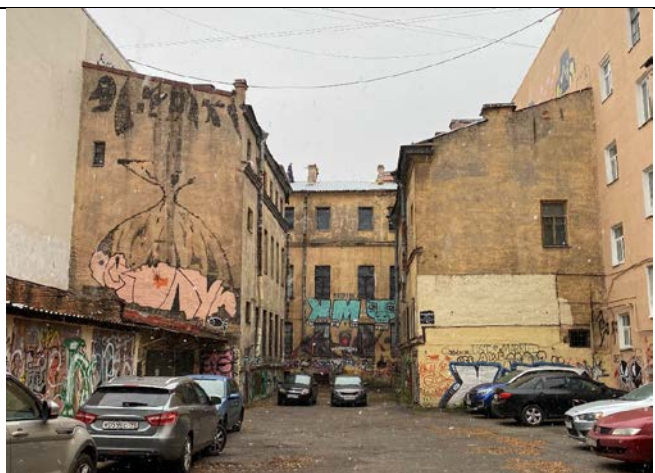
Фото № 2 – Здание, в котором находится Объект оценки. Вид со двора.
