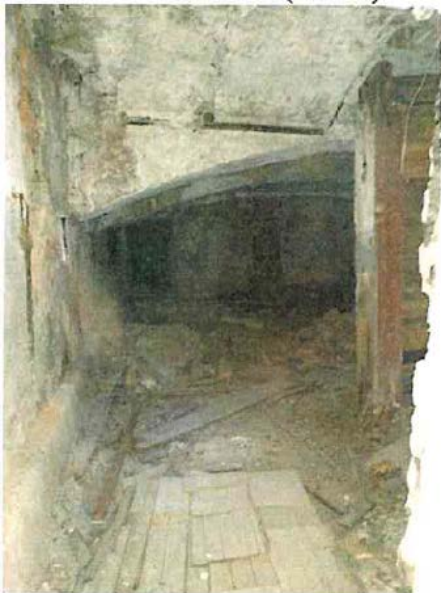
Фото № 7 – Внутреннее состояние
