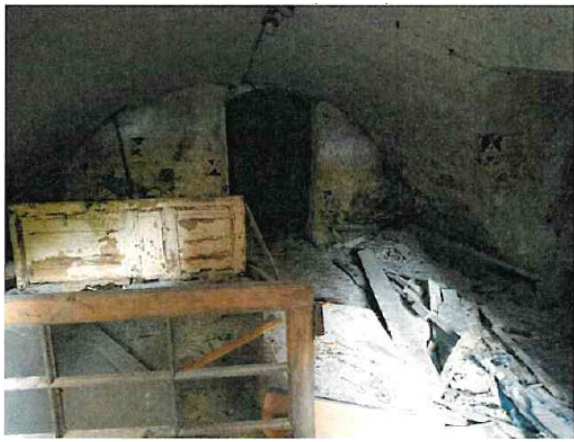
Фото № 7 – Внутреннее состояние
