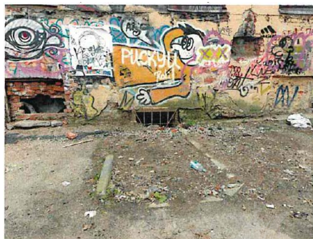
Фото № 6 – Вход в помещение
