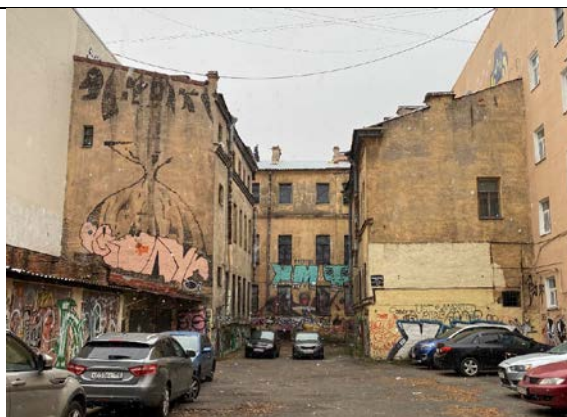
Фото № 2 – Здание, в котором находится Объект оценки. Вид со двора.
