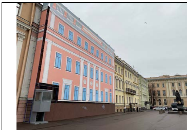
Фото № 1 – Здание, в котором находится Объект оценки. Вид с улицы.
