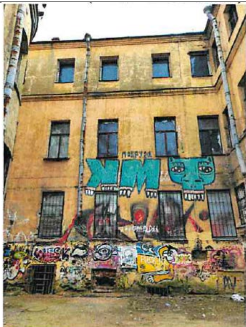
Фото № 5 – Вход в помещение
