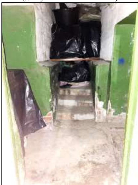
Фото 7. Общий вход со двора (защит), поход между пом. 19-Н и 20-Н
