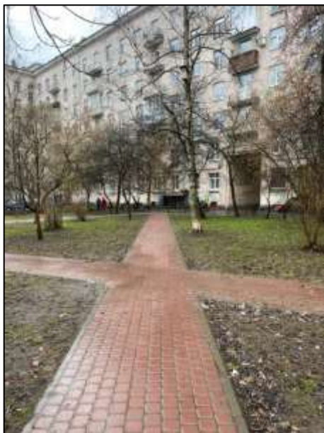
Фото 1. Вид здания, в котором расположен Объект оценки
