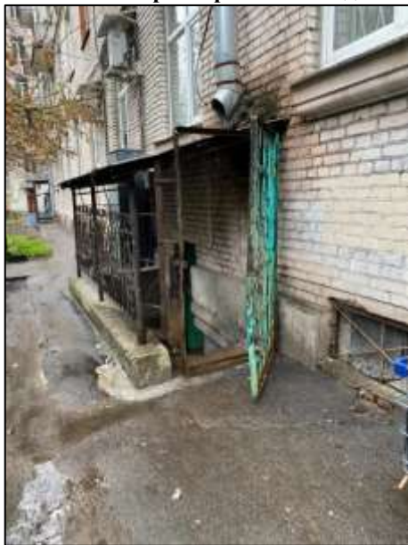
Фото 5. Отдельный вход со двора (доступ к пом. 19-Н и 20-Н)
