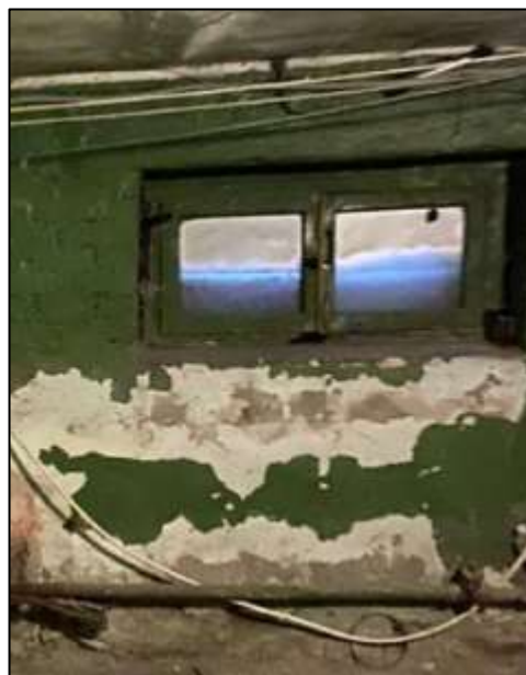
Фото 8. Оконный проем пом. 19-Н
