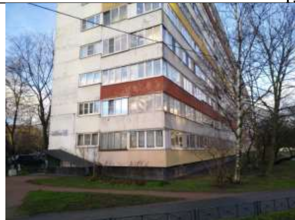
Фото 1. Вид здания, в котором расположен Объект оценки
