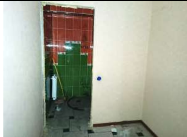
Фото 17. Внутреннее состояние Объекта оценки
