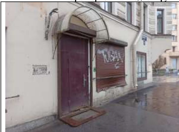
Фото 9. Отдельный вход с улицы и окно
