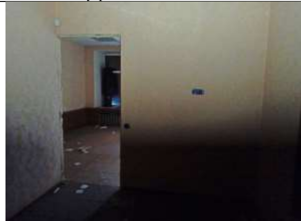
Фото 16. Внутреннее состояние Объекта оценки
