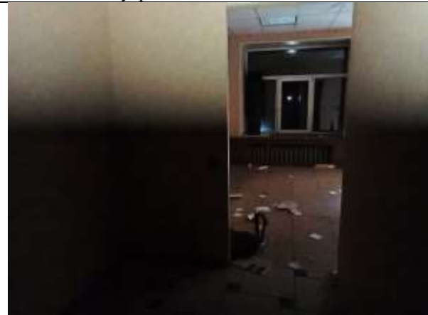
Фото 15. Внутреннее состояние Объекта оценки
