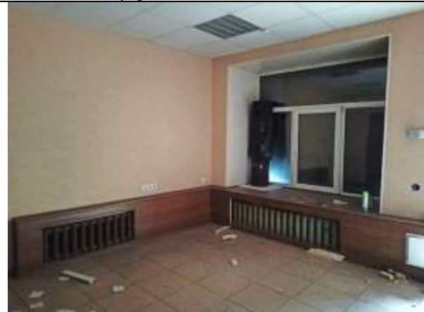
Фото 13. Внутреннее состояние Объекта оценки
