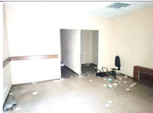
Фото 12. Внутреннее состояние Объекта оценки
