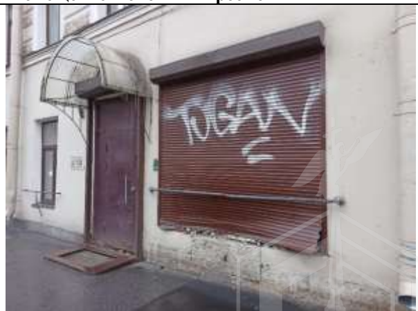
Фото 10. Отдельный вход с улицы и окно
