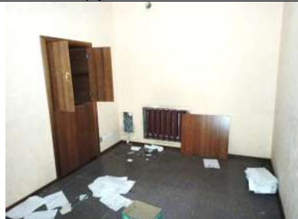
Фото 14. Внутреннее состояние Объекта оценки
