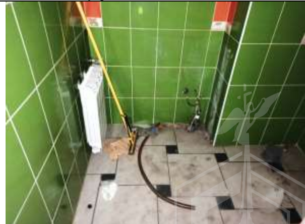
Фото 18. Внутреннее состояние Объекта оценки
