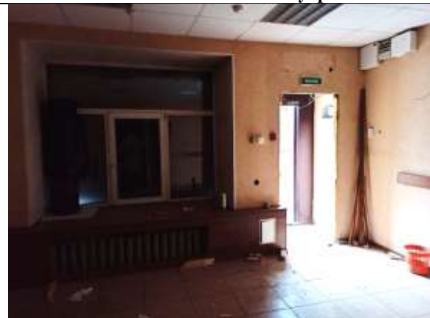
Фото 11. Внутреннее состояние Объекта оценки
