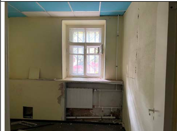
Фото 36. Типичное состояние Объекта оценки
