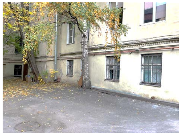
Фото 18. Внутри дворовая территория объекта оценки
