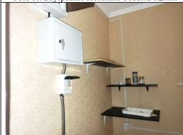
Фото 13. Внутреннее состояние Объекта оценки
