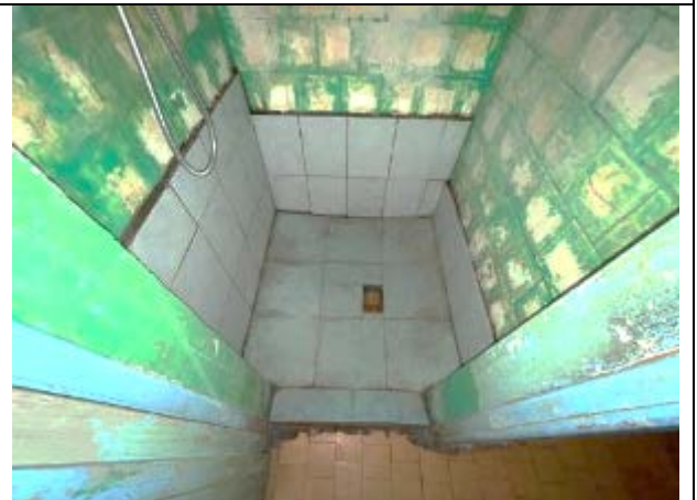
Фото 56. Типичное состояние Объекта оценки
