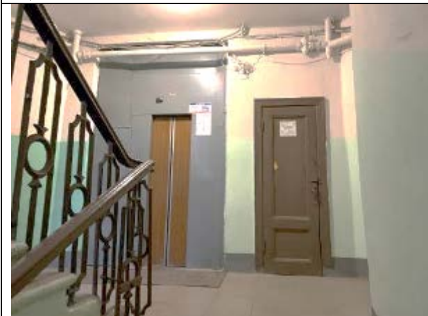
Фото 25. Состояние лестничной клетки Объекта оценки
