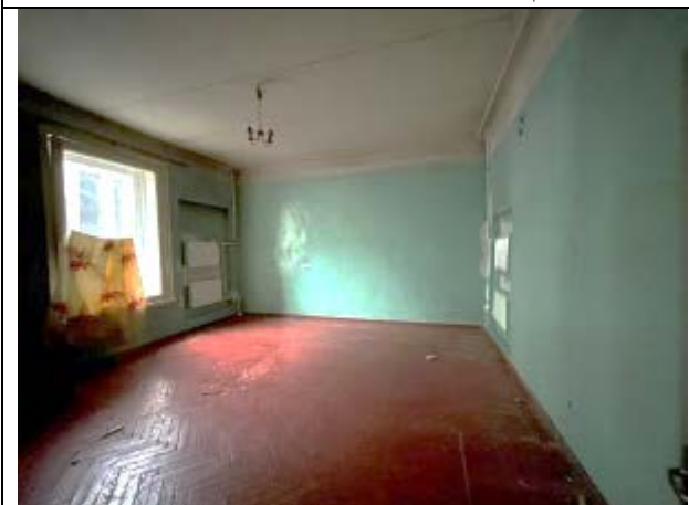
Фото 39. Типичное состояние Объекта оценки
