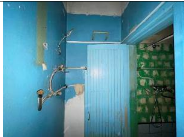
Фото 55. Типичное состояние Объекта оценки
