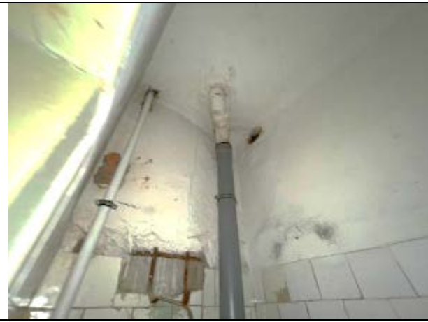
Фото 51. Типичное состояние Объекта оценки
