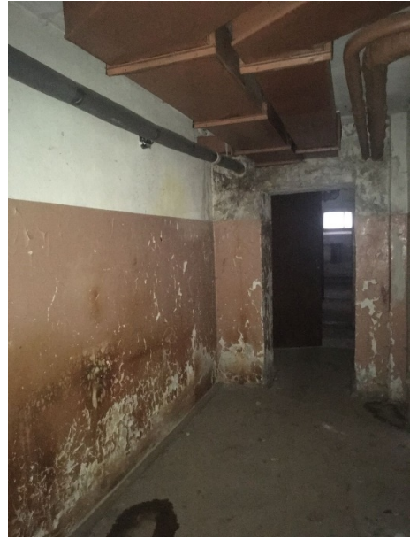
Фото 66. Проход в пом. 1-Н
