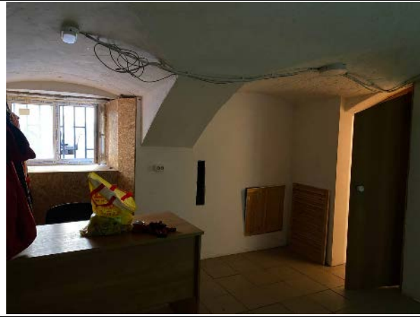
Фото № 13 – Внутреннее состояние
