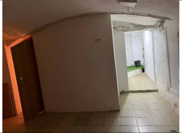
Фото № 14 – Внутреннее состояние
