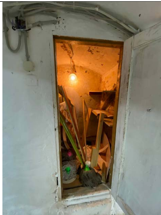
Фото № 20 – Внутреннее состояние
