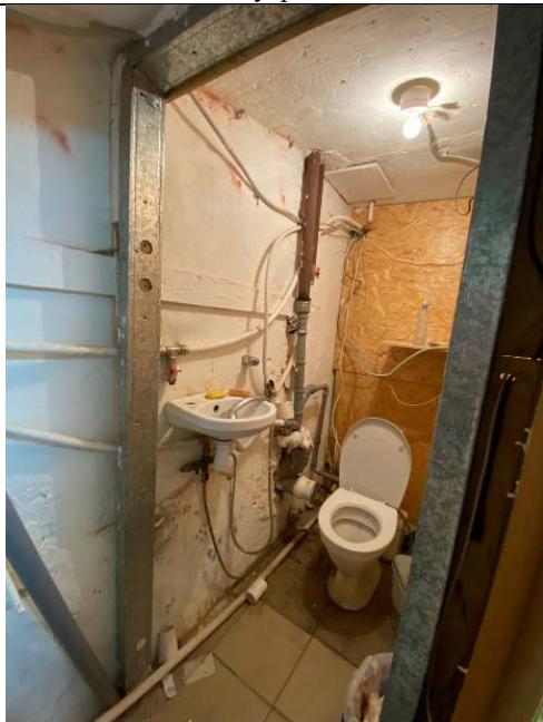
Фото № 17 – Внутреннее состояние
