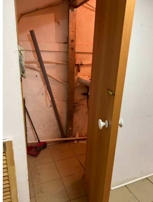
Фото № 16 – Внутреннее состояние
