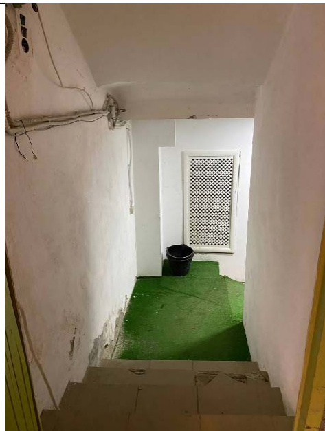
Фото № 8 – Внутреннее состояние
