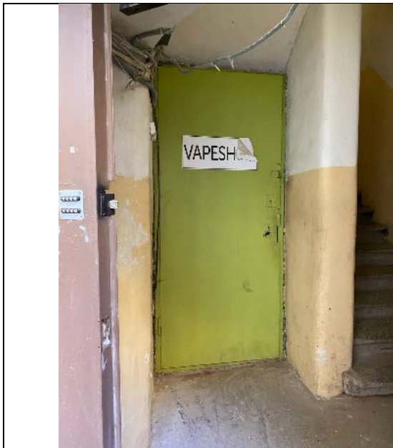
Фото № 7 – Вход в помещение 9-Н
