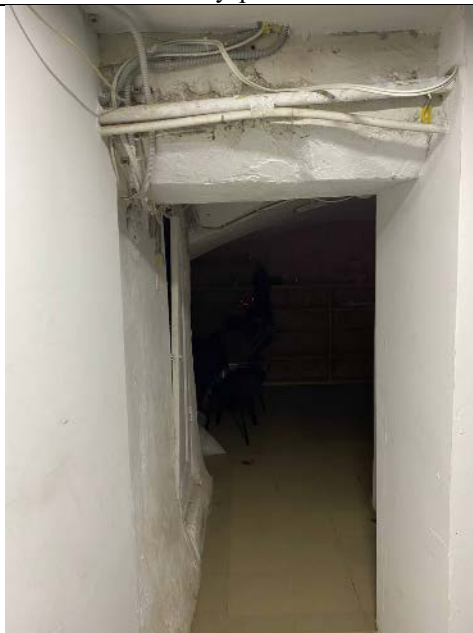
Фото № 10 – Внутреннее состояние
