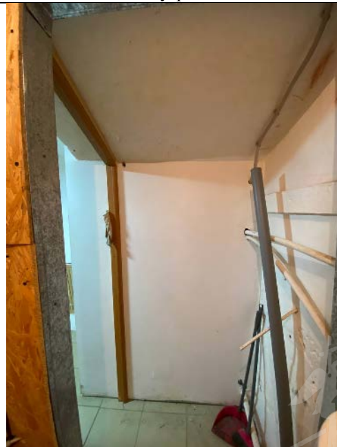
Фото № 18 – Внутреннее состояние
