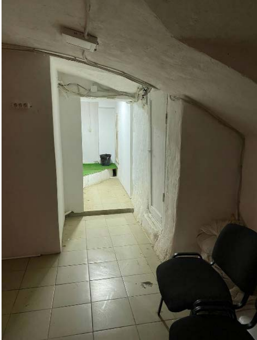
Фото № 15 – Внутреннее состояние
