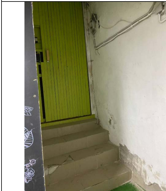
Фото № 9 – Внутреннее состояние
