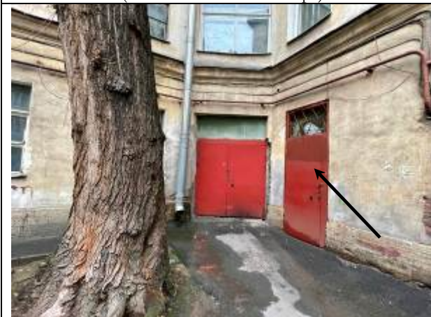
Фото 35. Входная группа помещения 13-Н (отдельный вход со двора)
