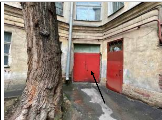
Фото 33. Входная группа помещения 12-Н (отдельный вход со двора)
