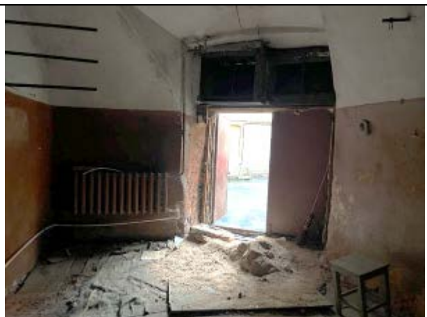
Фото 34. Входная группа помещения 12-Н (отдельный вход со двора)
