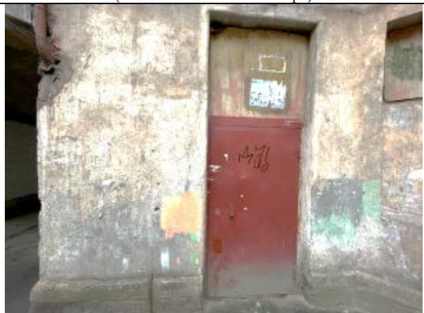
Фото 36. Входная группа помещения 13-Н (отдельный вход со двора)
