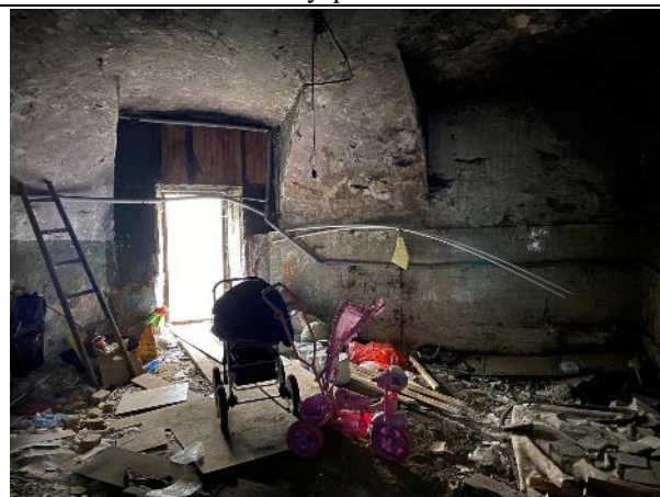
Фото № 11 – Внутреннее состояние
