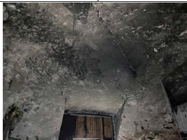
Фото № 9 – Внутреннее состояние
