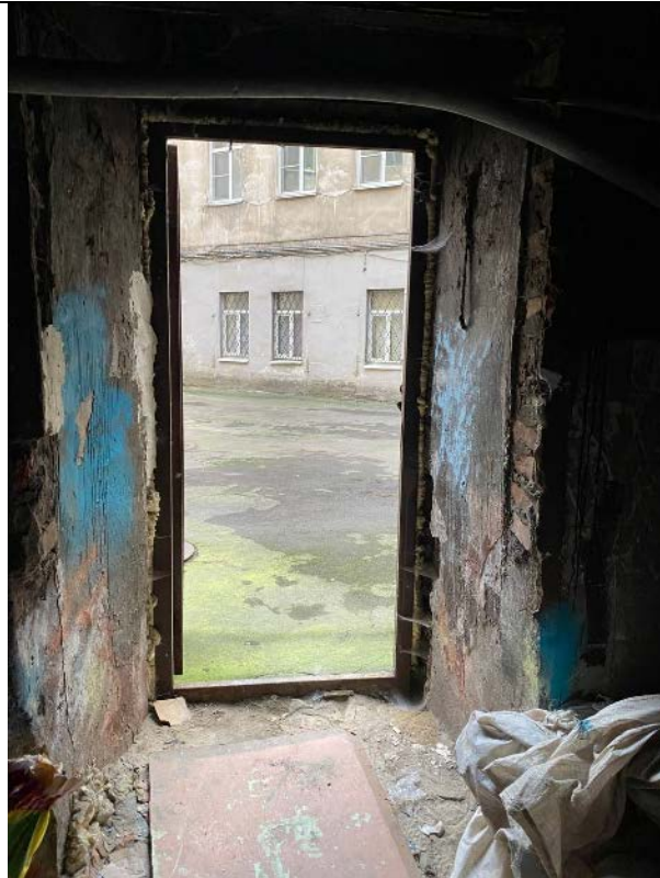
Фото № 6 – Отдельный вход в помещение 8-Н со двора
