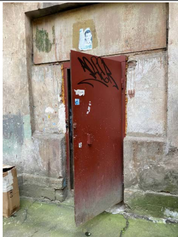
Фото № 7 – Отдельный вход в помещение 8-Н со двора
