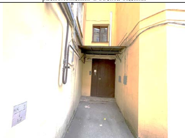
Фото 34. Входная группа Объекта оценки (общий вход со двора)
