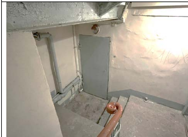
Фото 41. Входная группа Объекта оценки (общий вход со двора)
