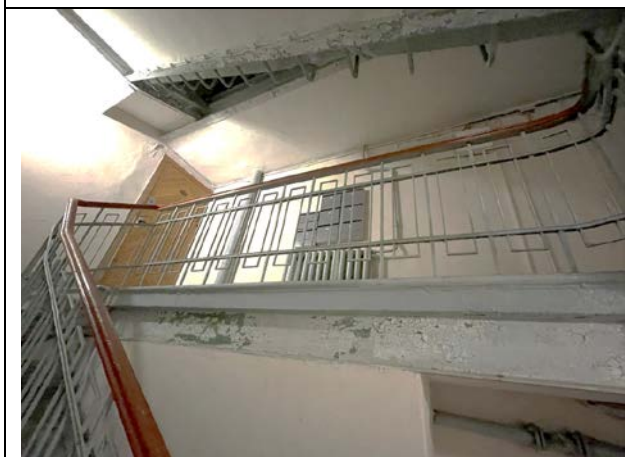
Фото 39. Лестничный проём парадной жилого дома Объекта оценки
