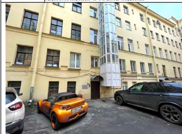
Фото 33. Входная группа Объекта оценки (общий вход со двора)
