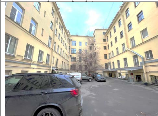
Фото 31. Внутри дворовая территория здания расположения Объекта оценки
