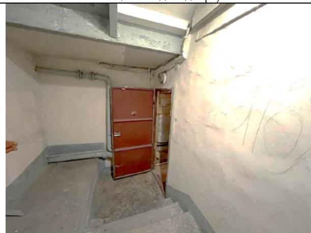
Фото 42. Входная группа Объекта оценки (общий вход со двора)
