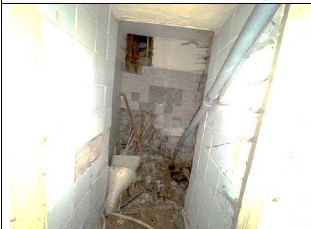
Фото 49. Типичное состояние Объекта оценки
