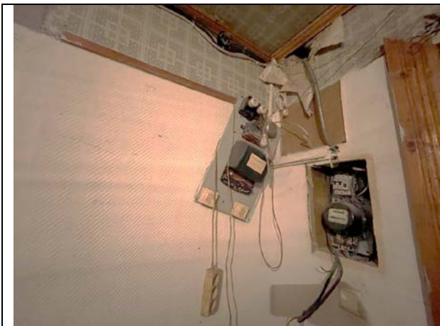
Фото 53. Типичное состояние Объекта оценки
