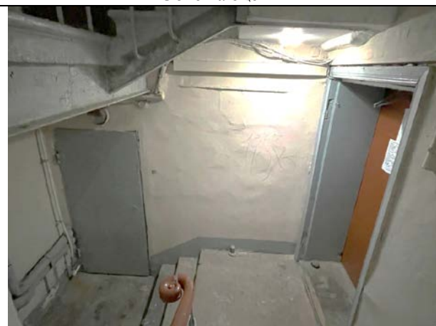
Фото 40. Входная группа Объекта оценки (общий вход со двора)
