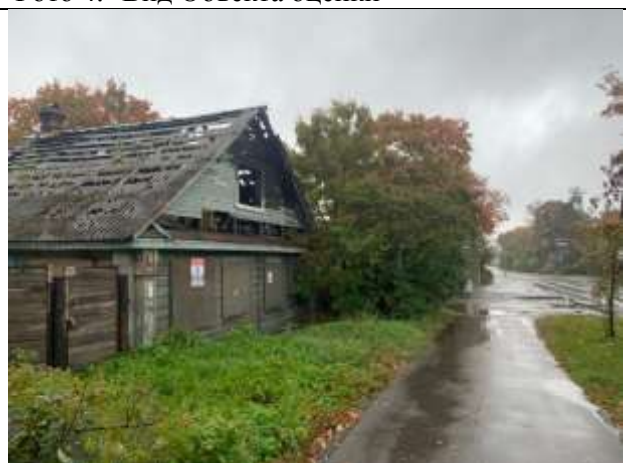
Фото 6. Вид Объекта оценки и подъездных путей
