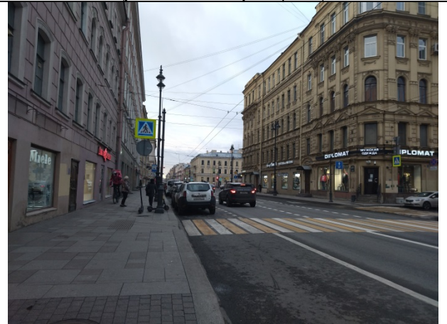
Фото 10. Ближайшее окружение Объекта оценки (Большой проспект П.С.)
