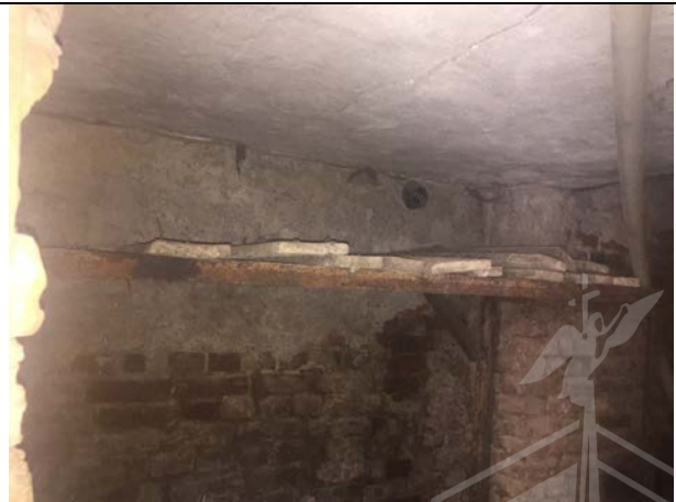
Фото 22. Типичное состояние Объекта оценки
