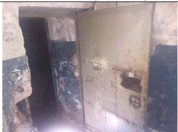
Фото 20. Типичное состояние Объекта оценки
