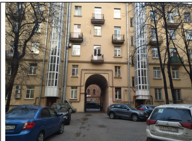
Фото 15. Внутри дворовая территория
