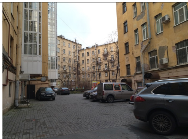
Фото 16. Внутри дворовая территория
