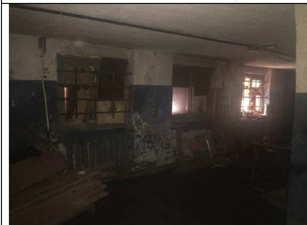
Фото 25. Типичное состояние Объекта оценки
