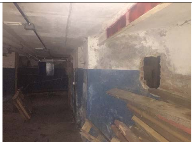
Фото 24. Типичное состояние Объекта оценки
