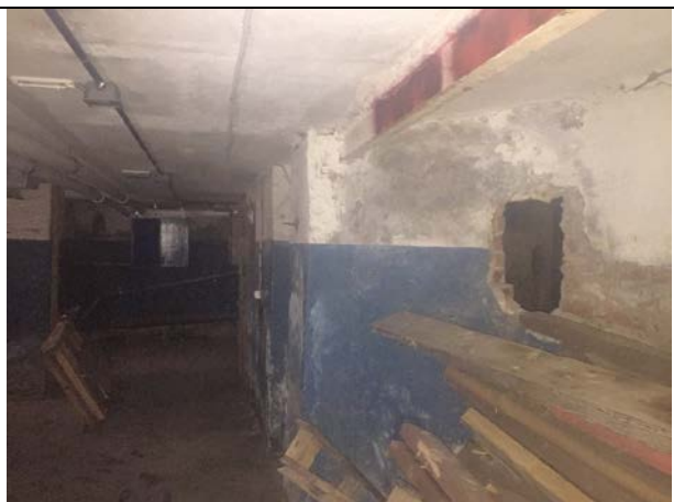
Фото 24. Типичное состояние Объекта оценки
