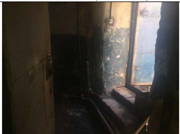
Фото 19. Типичное состояние Объекта оценки
