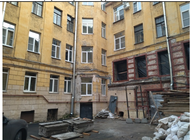
Фото 18. Вход в помещение (Объект оценки)
