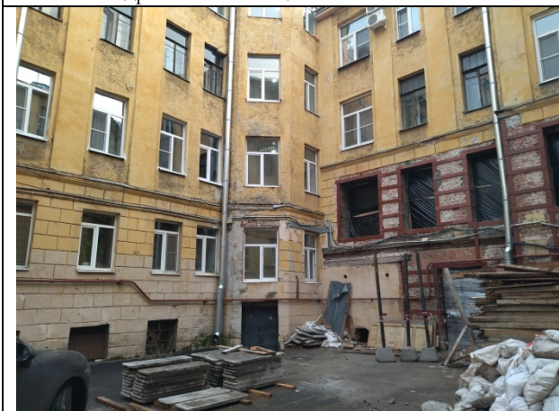
Фото 13. Внутри дворовая территория
