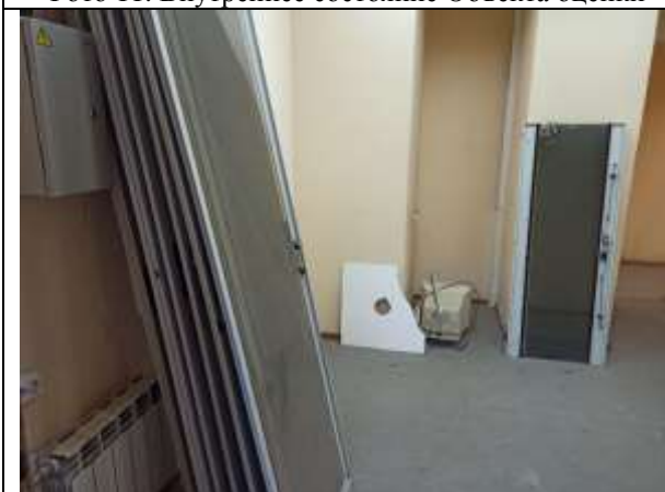
Фото 13. Внутреннее состояние Объекта оценки
