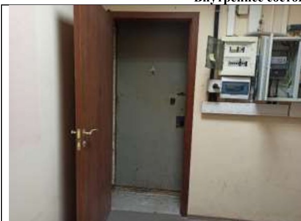
Фото 11. Внутреннее состояние Объекта оценки
