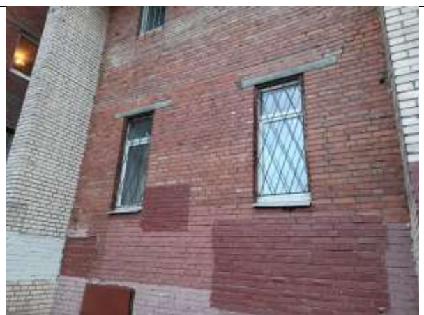
Фото 10. Вид окон Объекта оценки
