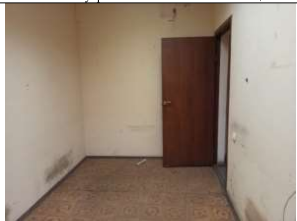
Фото 20. Внутреннее состояние Объекта оценки
