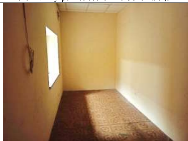
Фото 26. Внутреннее состояние Объекта оценки
