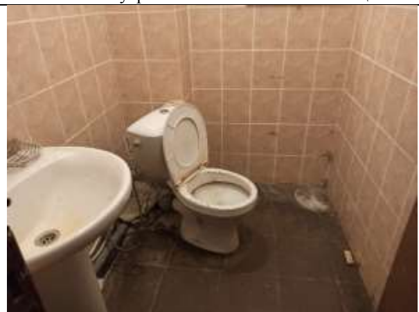
Фото 18. Внутреннее состояние Объекта оценки
