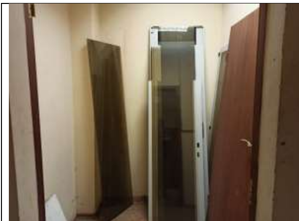
Фото 15. Внутреннее состояние Объекта оценки
