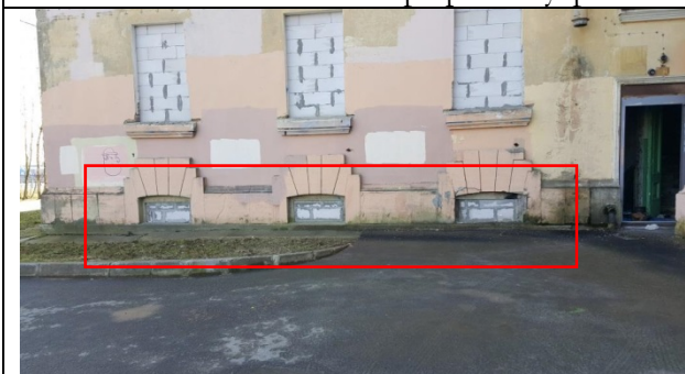
Фото 13. Вид оконной группы помещения 1-Н
