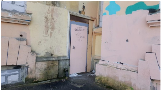
Фото 8. Вид общего входа в Объекты оценки
