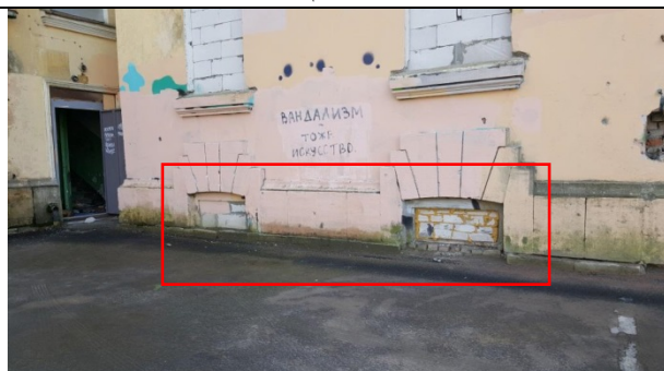
Фото 14. Вид оконной группы помещения 3-Н
