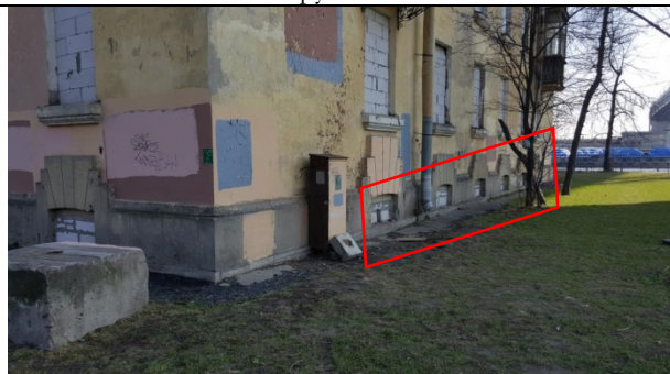
Фото 16. Вид оконной группы помещения 4-Н
