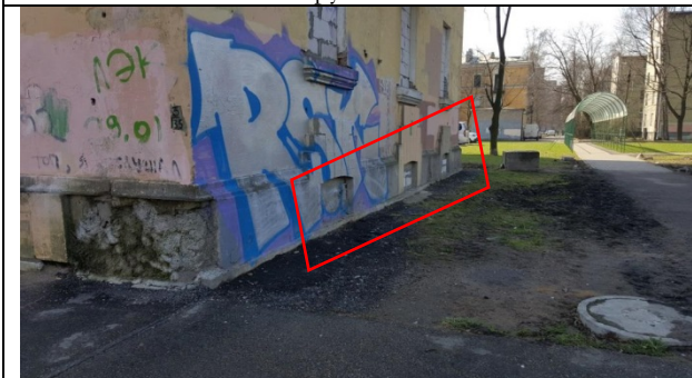
Фото 15. Вид оконной группы помещения 4-Н
