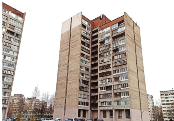
Фото 2. Вид здания, в котором расположен Объект оценки, со двора
