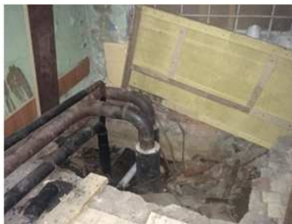
Фото 16. В ч.п. 4 находится транзитный трубопровод, оборудованный через приямок
