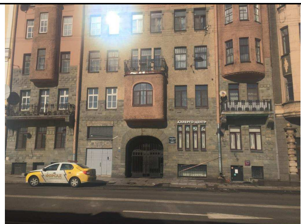
Фото 6. Вид здания Объекта оценки
