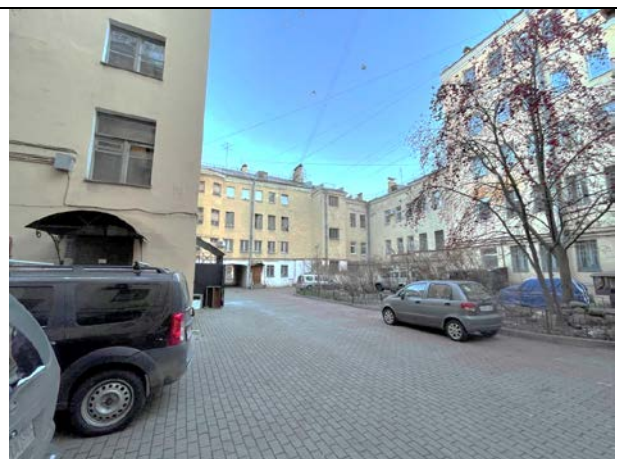
Фото 28. Внутри дворовая территория Объекта оценки
