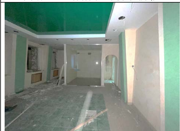
Фото 46. Типичное состояние Объекта оценки
