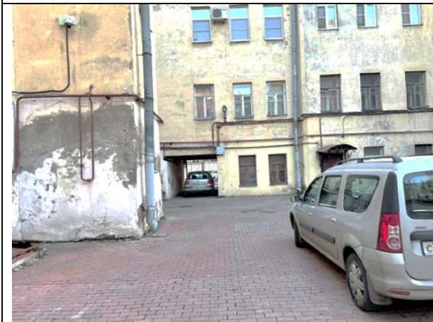
Фото 30. Внутри дворовая территория Объекта оценки
