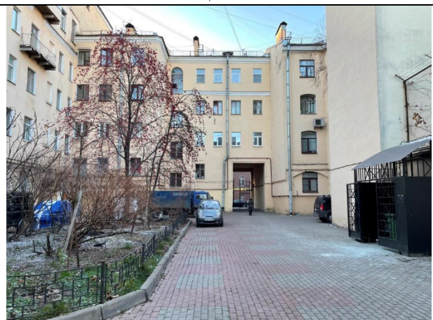
Фото 29. Внутри дворовая территория Объекта оценки
