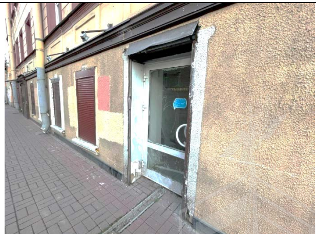
Фото 33. Входная и оконная группа (отдельный вход с улицы)
