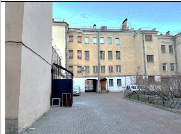
Фото 32. Внутри дворовая территория Объекта оценки
