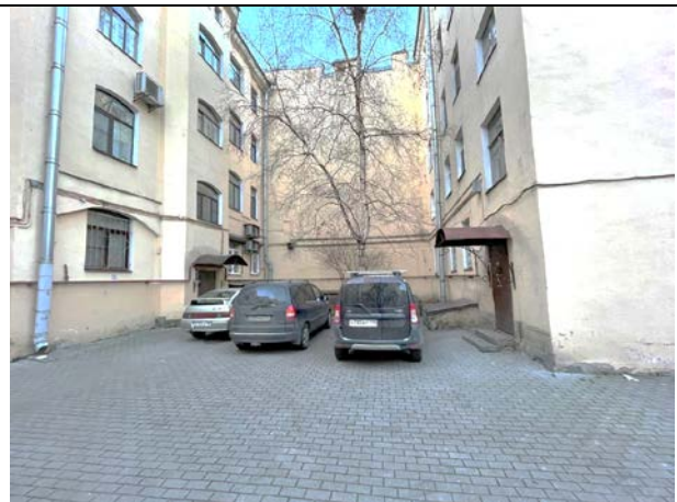
Фото 31. Внутри дворовая территория Объекта оценки
