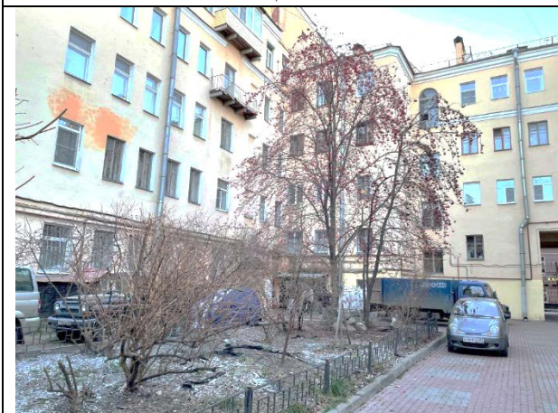
Фото 28. Внутри дворовая территория Объекта оценки
