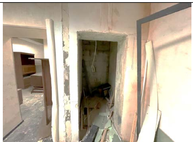
Фото 43. Типичное состояние Объекта оценки
