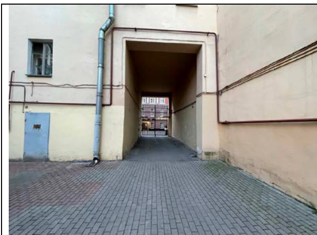
Фото 27. Внутри дворовая территория Объекта оценки
