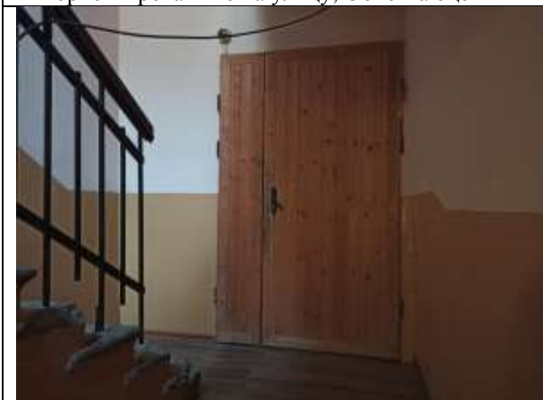
Фото 9. Общий с нежилыми помещениями вход со двора (вид изнутри здания)
