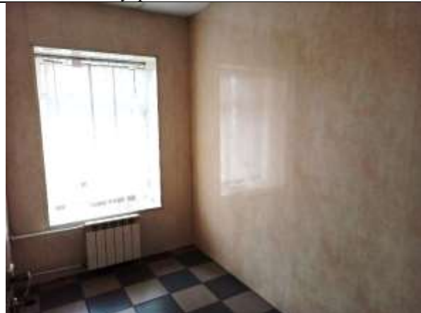
Фото 16. Внутреннее состояние Объекта оценки
