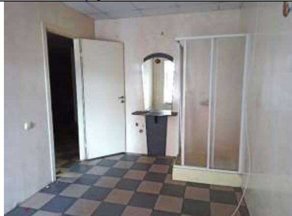
Фото 14. Внутреннее состояние Объекта оценки
