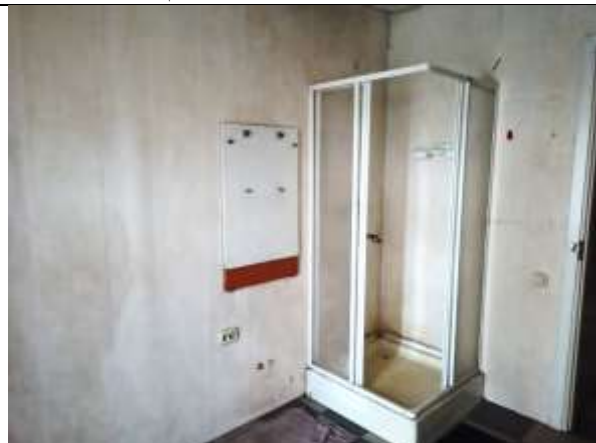
Фото 12. Внутреннее состояние Объекта оценки
