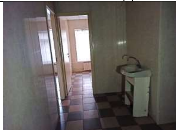
Фото 11. Внутреннее состояние Объекта оценки
