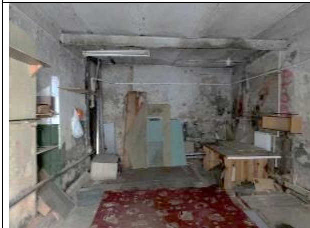
Фото 27. Типичное состояние объекта оценки
