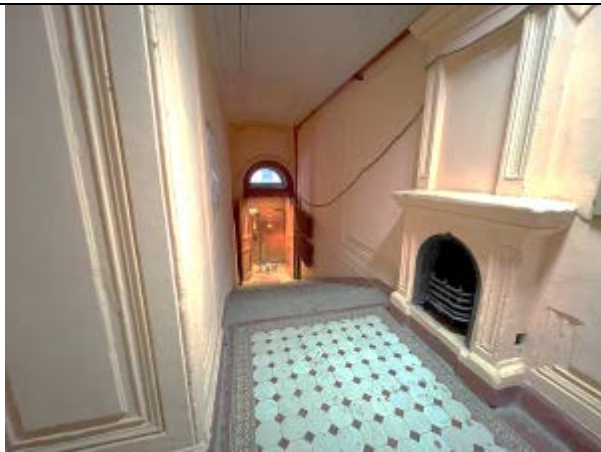
Фото 25. Общий вход с улицы
