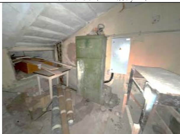
Фото 27. Общий вид Объекта оценки
