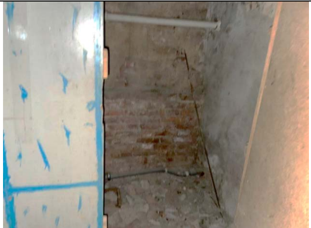
Фото 38. Типичное состояние Объекта оценки
