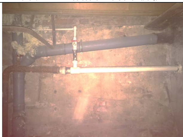
Фото 44. Типичное состояние Объекта оценки
