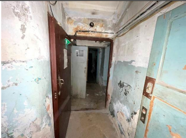
Фото 37. Типичное состояние Объекта оценки
