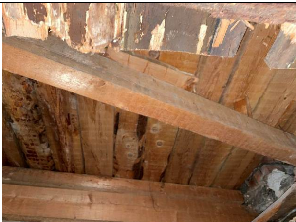
Фото 39. Типичное состояние Объекта оценки
