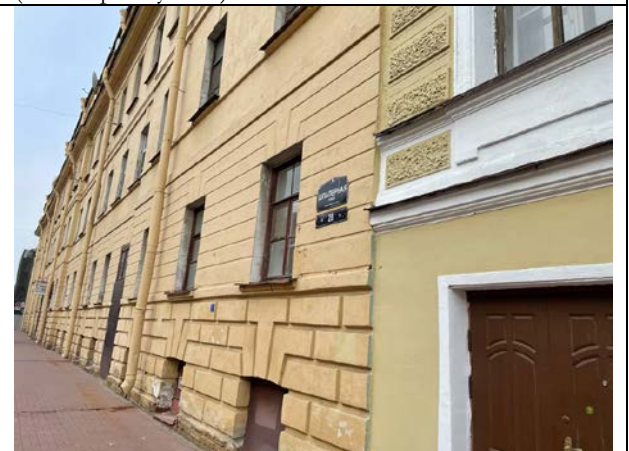
Фото 8. Вид здания расположения Объекта оценки
