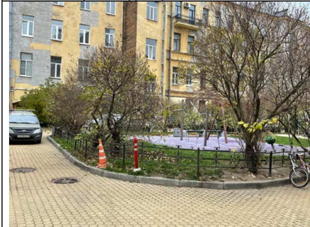
Фото 13. Дворовая территория Объекта оценки
