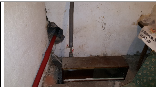
Фото 21. Типичное состояние Объекта оценки
