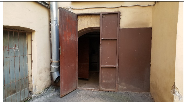
Фото 16. Вид общего входа в Объект оценки со двора
