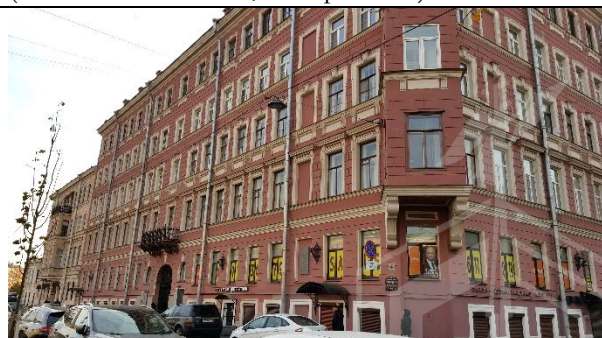
Фото 10. Вид здания расположения Объекта оценки
