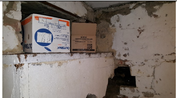
Фото 24. Типичное состояние Объекта оценки
