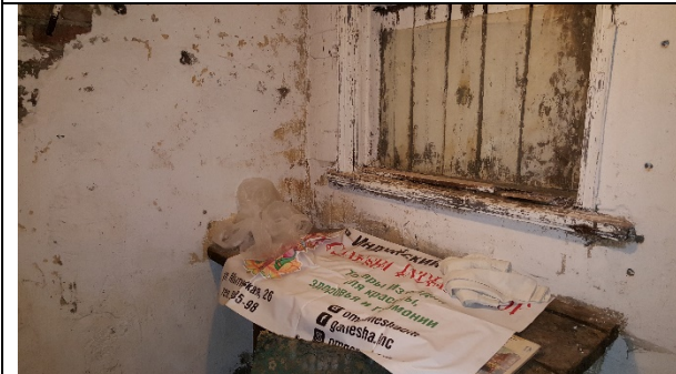
Фото 23. Типичное состояние Объекта оценки
