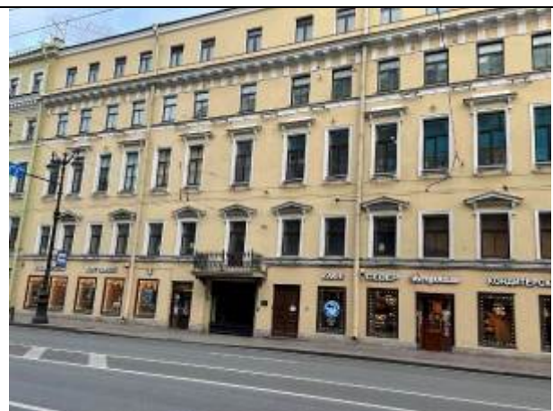
Фото 14. Вид здания расположения Объекта оценки
