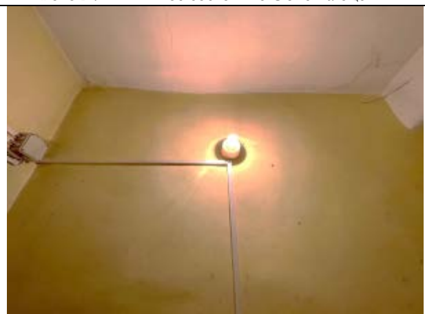
Фото 26. Типичное состояние Объекта оценки
