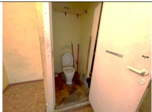
Фото 24. Типичное состояние Объекта оценки
