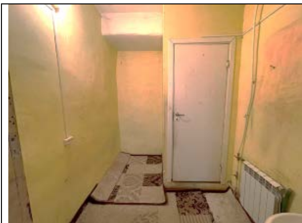
Фото 21. Типичное состояние Объекта оценки
