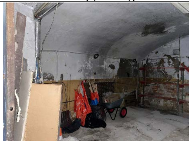
Фото № 7 – Внутреннее состояние помещения 8-Н
