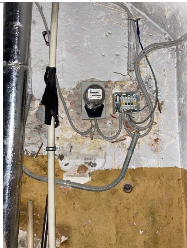
Фото № 13 – Внутреннее состояние помещения 8-Н
