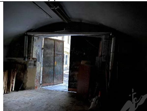
Фото № 10 – Внутреннее состояние помещения 8-Н
