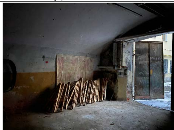
Фото № 9 – Внутреннее состояние помещения 8-Н
