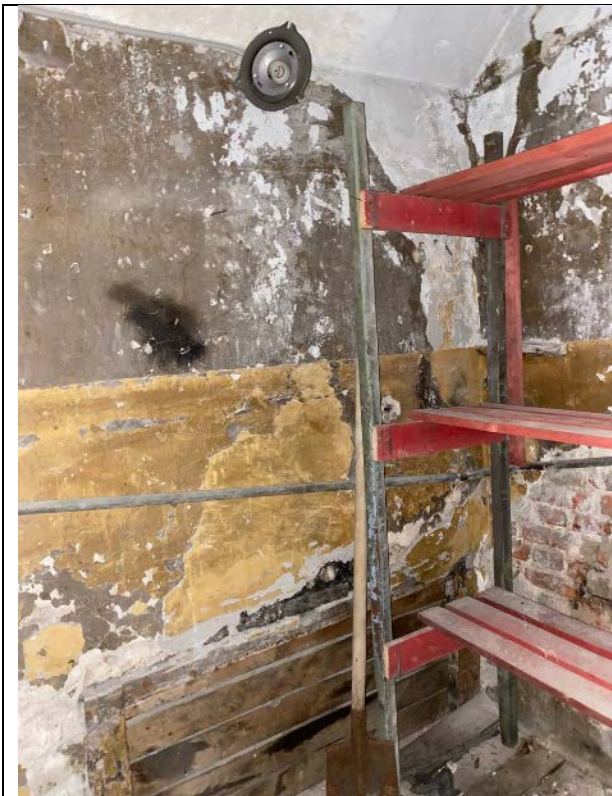
Фото № 11 – Внутреннее состояние помещения 8-Н
