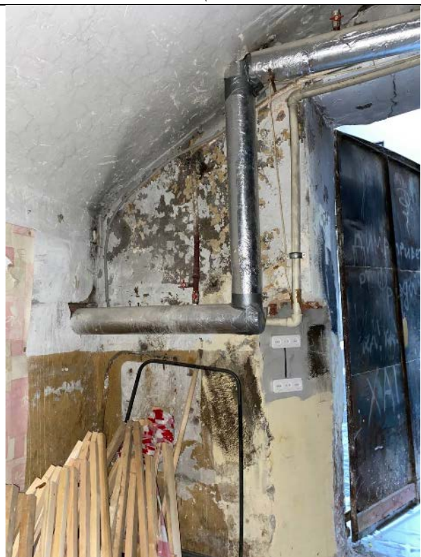
Фото № 14 – Внутреннее состояние помещения 8-Н
