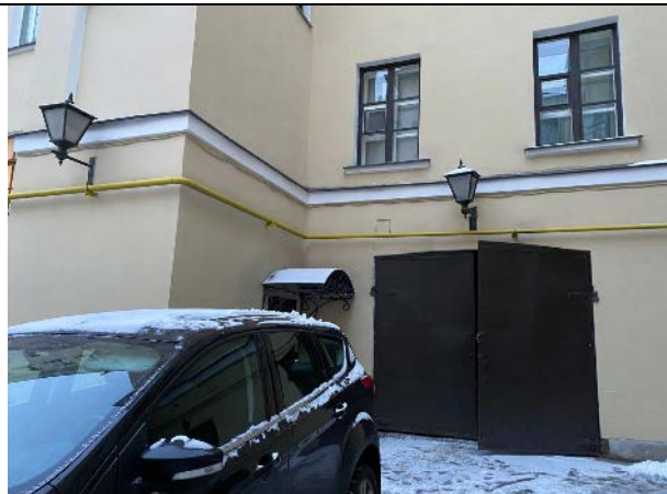
Фото № 4 – Отдельный вход в помещение со двора
