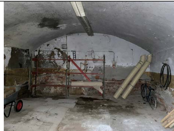
Фото № 8 – Внутреннее состояние помещения 8-Н
